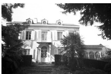
Vue générale de la façade antérieure Phot. Y. Desdoigts IVR53_19783501046Z
