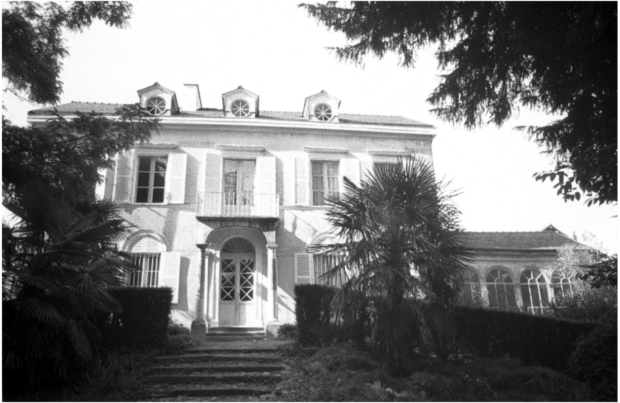
Vue générale de la façade antérieure
