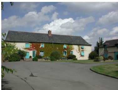
Ferme : vue d'ensemble Repro. Véronique Orain IVR53_20013515398NUCA
