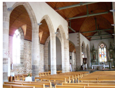
Trégunc, église paroissiale Saint- Marc : vue transversale nord-est Phot. Gwénaél Fauchille IVR53_20082905625NUCA
