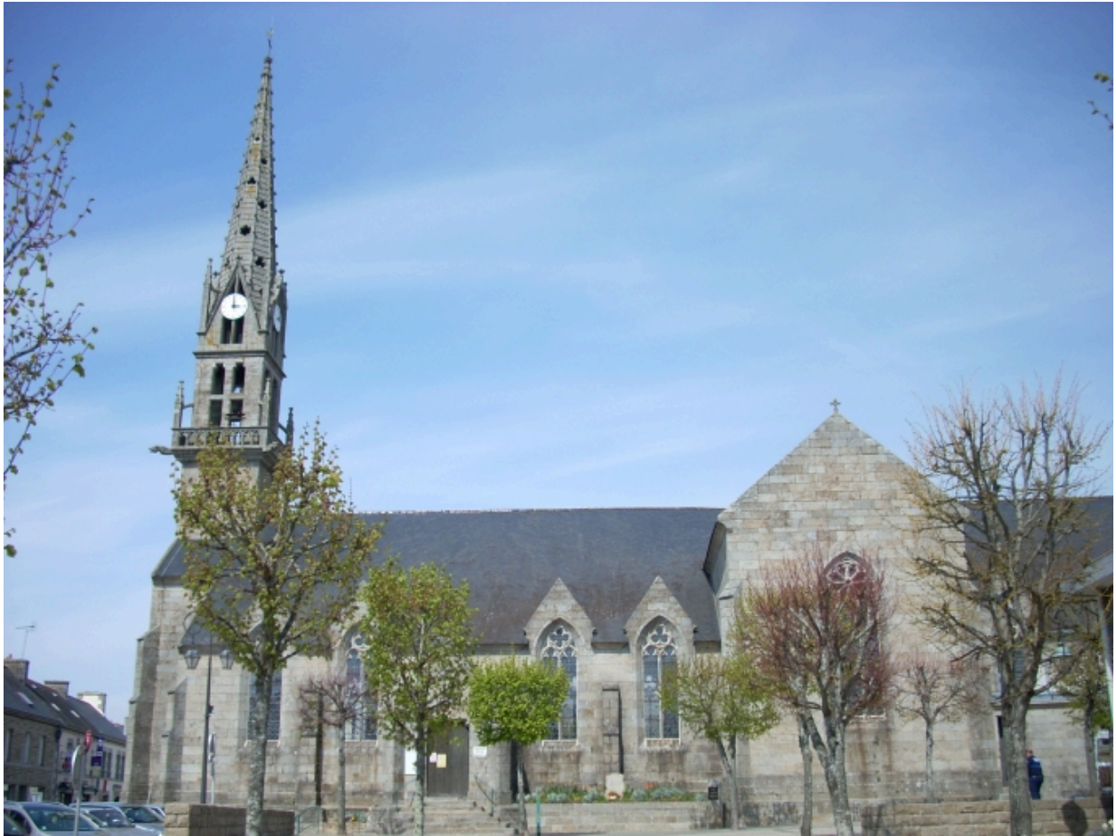
Trégunc, église paroissiale Saint-Marc : élévation sud
