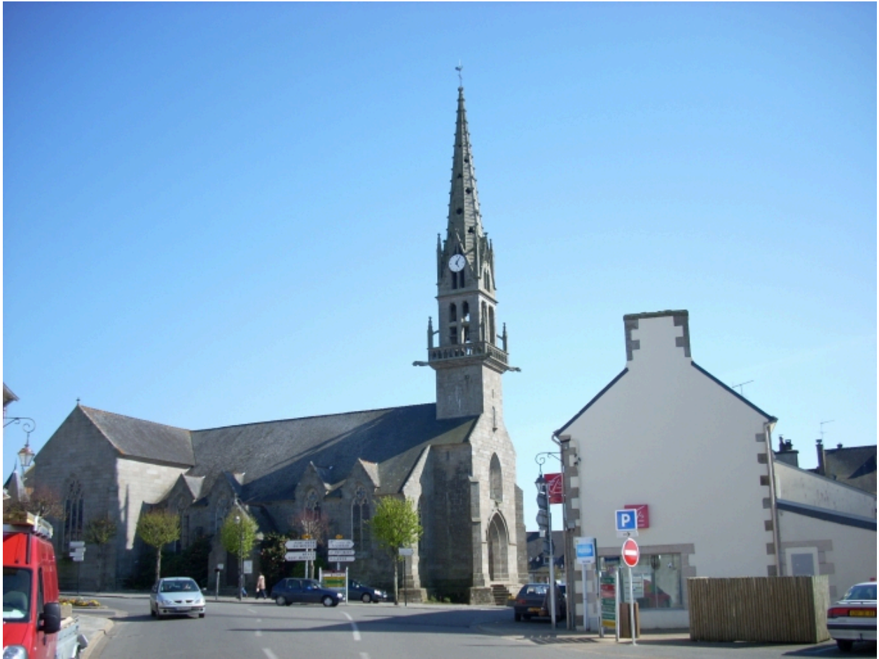
Trégunc, église paroissiale Saint-Marc : vue générale nord-ouest
