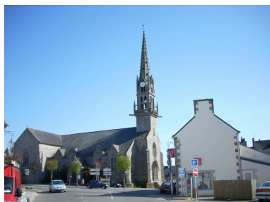
Trégunc, église paroissiale Saint-Marc : vue générale nord-ouest Phot. Gwénaél Fauchille IVR53_20082905620NUCA
