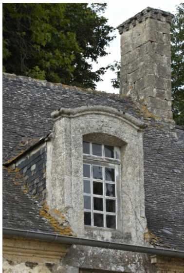
Communs, lucarne datée 1739 Phot. Rozenn Turni IVR53_20102203464NUCA
