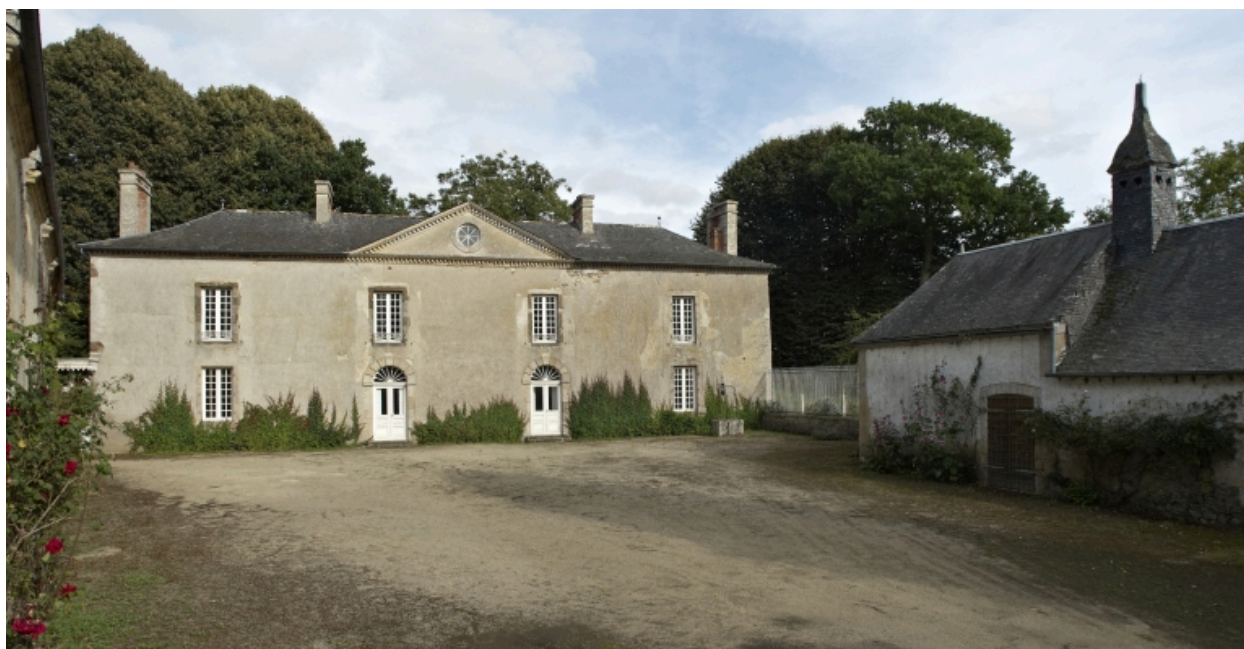
Logis, vue générale de la façade ouest
