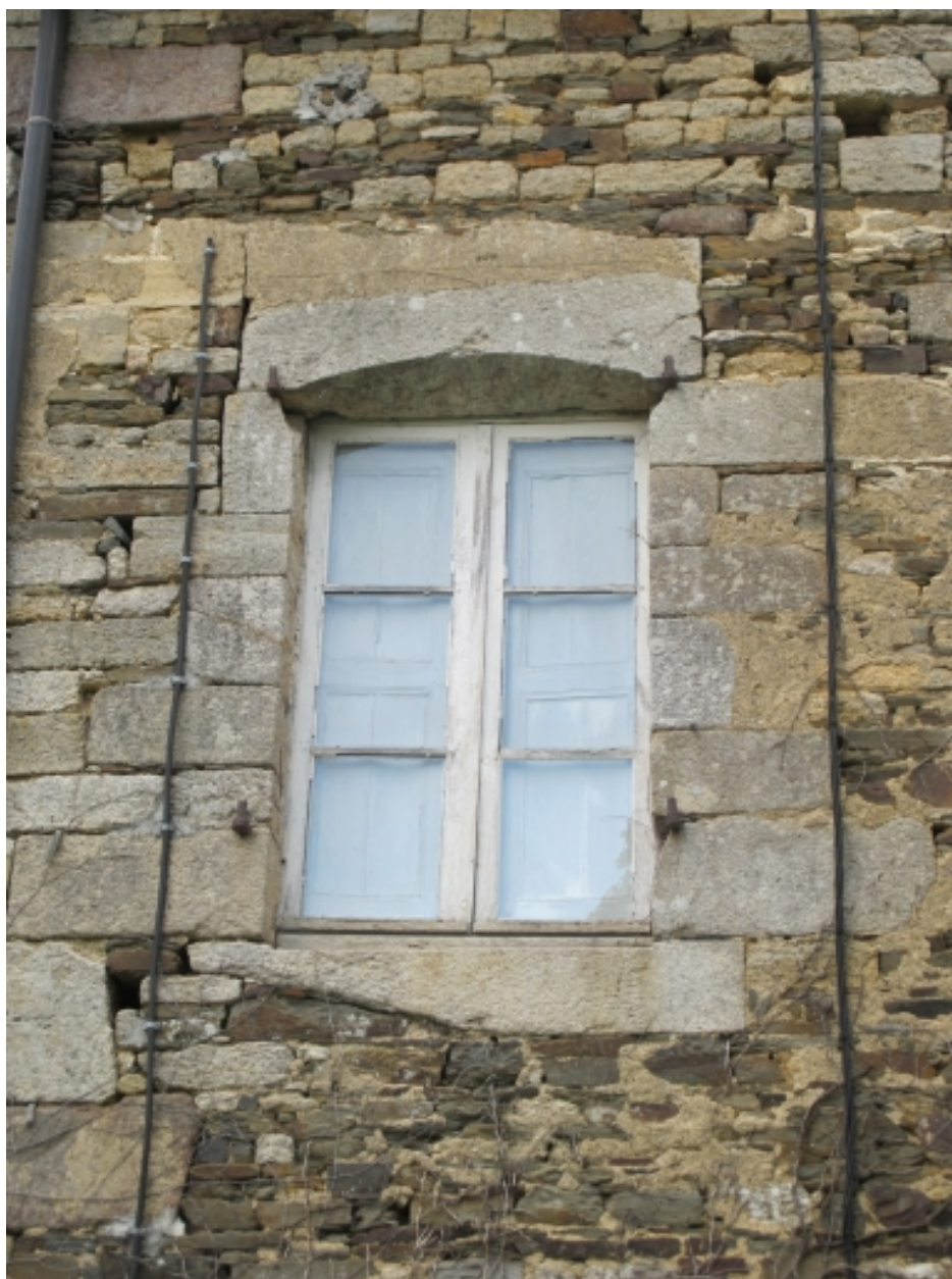
Logis, pignon sud, détail de la fenêtre de la chambre
