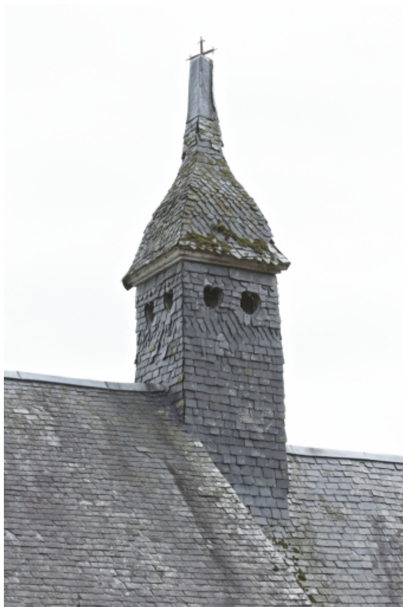
Chapelle, clocher de charpente
