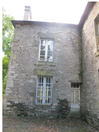
Logis, aile arrière Phot. Véronique Orain IVR53_20102211868NUCA
