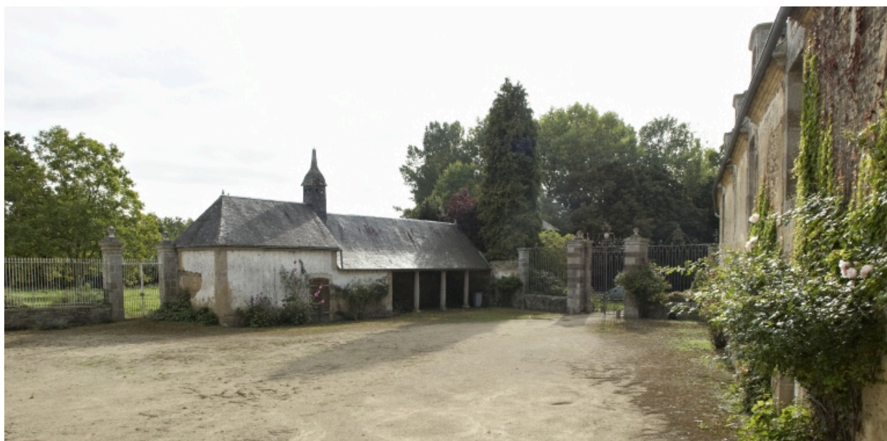
Chapelle et remise formant une aile au sud de la cour
