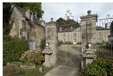
Portail d'entrée Phot. Rozenn Turni IVR53_20102203453NUCA
