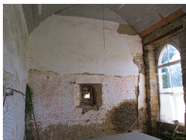
Chapelle, vue intérieure, vestiges de peintures murales Phot. Véronique Orain IVR53_20102211896NUCA
