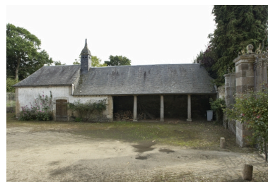
Chapelle et remise , aile sud Phot. Rozenn Turni IVR53_20102203458NUCA
