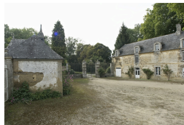
La cour de l'ouest vers l'est Phot. Rozenn Turni IVR53_20102203462NUCA
