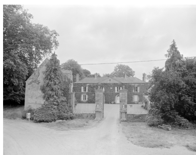
Vue générale prise de l'Ouest Phot. Guy Artur, Phot. Norbert Lambart IVR53_19872200190X
