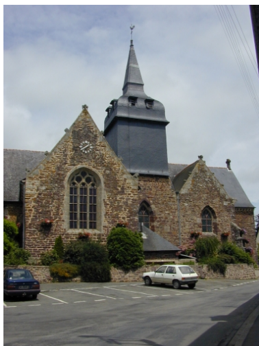
Vue générale sud Phot. Sabrina Dalibard IVR53_20033513278NUCA
