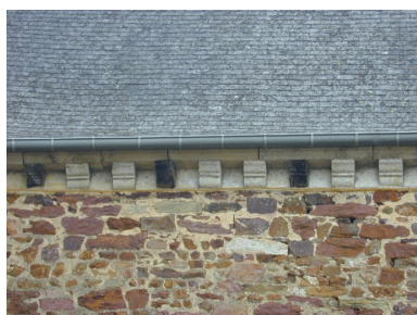
Détail de la corniche Phot. Sabrina Dalibard IVR53_20033513283NUCA
