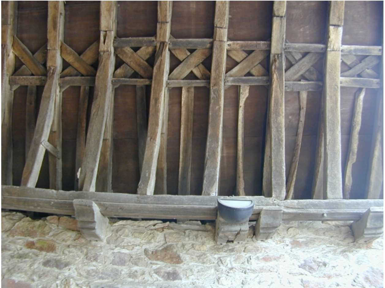
Détail de la charpente du porche
