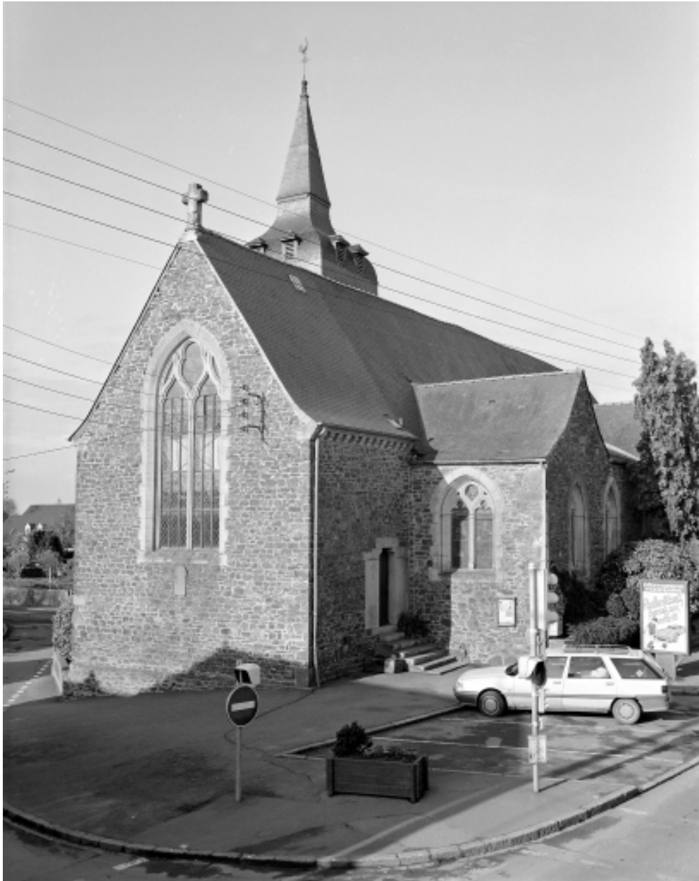
Elévation Est : vue générale
