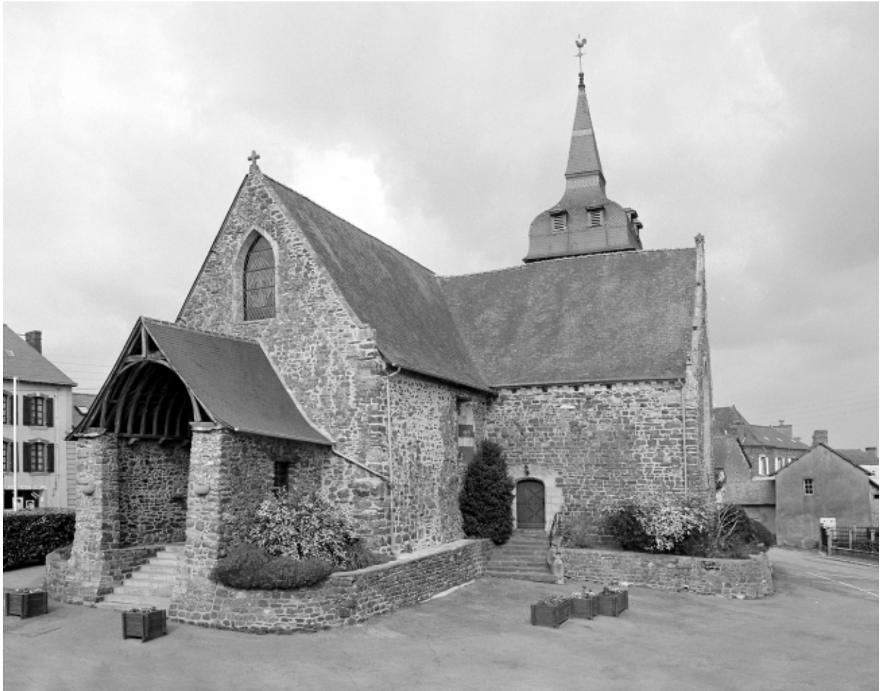
Elévation Sud-Ouest : vue générale
