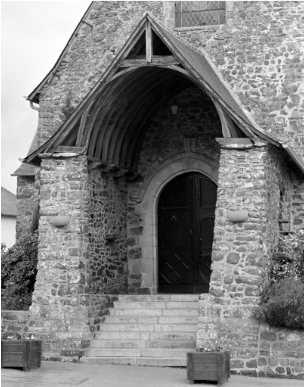
Elevation Ouest, porche : vue générale
