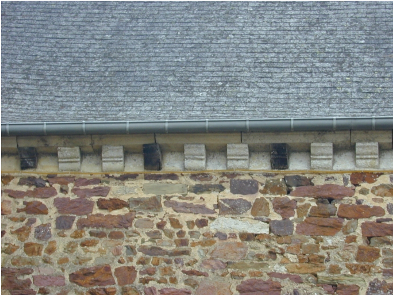
Détail de la corniche
