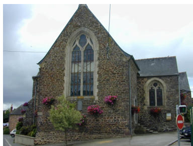
Façade est de l'église Phot. Sabrina Dalibard IVR53_20033513282NUCA
