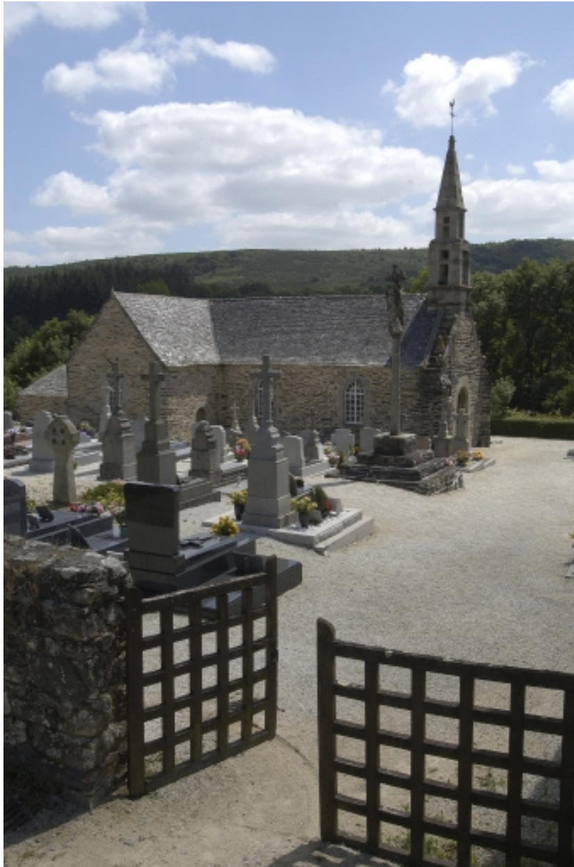
Saint-Rivoal, église paroissiale Saint-Rivoal : vue générale nord. Etat en 2006
