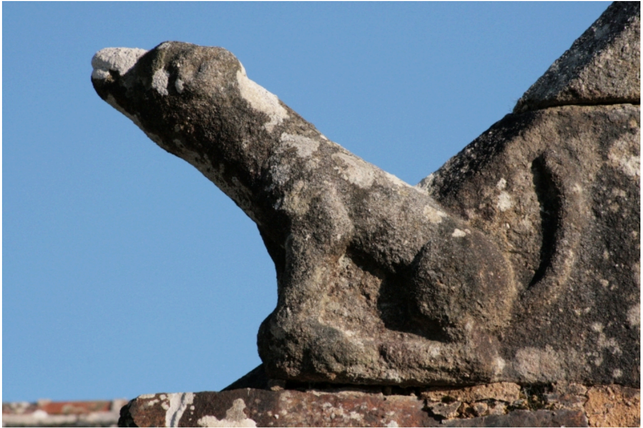
Saint-Rivoal, église paroissiale Saint-Rivoal : pignon ouest, partie nord, crossette ornée d'un lion
