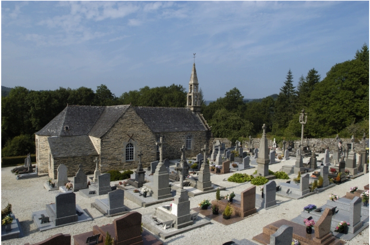
Saint-Rivoal, église paroissiale Saint-Rivoal : vue générale nord-est
