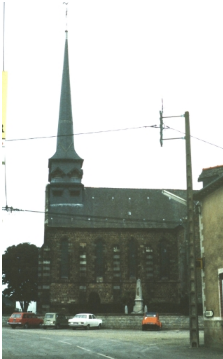
Clocher : vue générale depuis le sud
