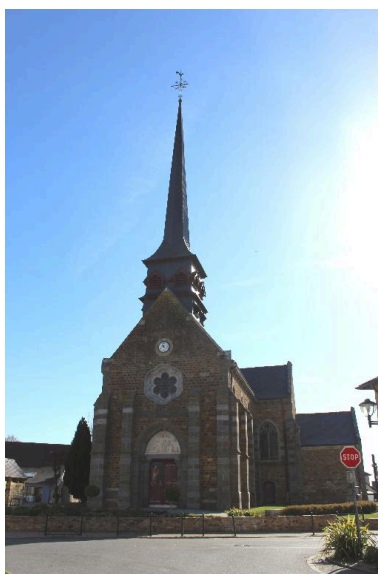
Façade principale Phot. Déborah De Sousa Figueiredo IVR53_20163505340NUCA
