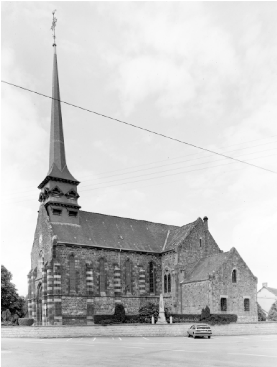
Elévation sud-ouest : vue générale
