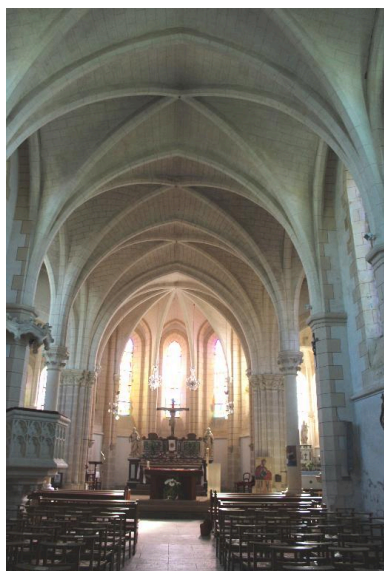
Intérieur de la nef Phot. Déborah De Sousa Figueiredo IVR53_20163505345NUCA
