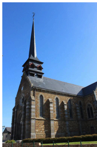
Elévation sud de la nef Phot. Déborah De Sousa Figueiredo IVR53_20163505341NUCA
