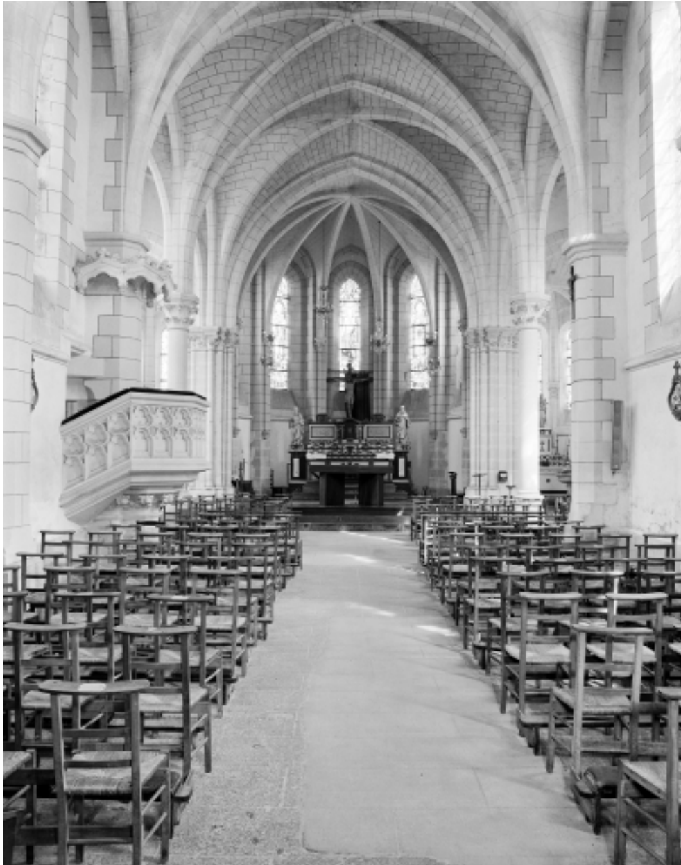
Intérieur : vue générale vers le chœur.
