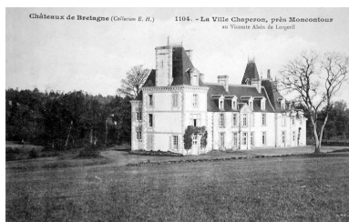
Vue générale sud Phot. Elise Lauranceau IVR53_20042209068NUCB
