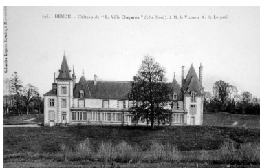
Vue générale nord Phot. Elise Lauranceau IVR53_20042209067NUCB
