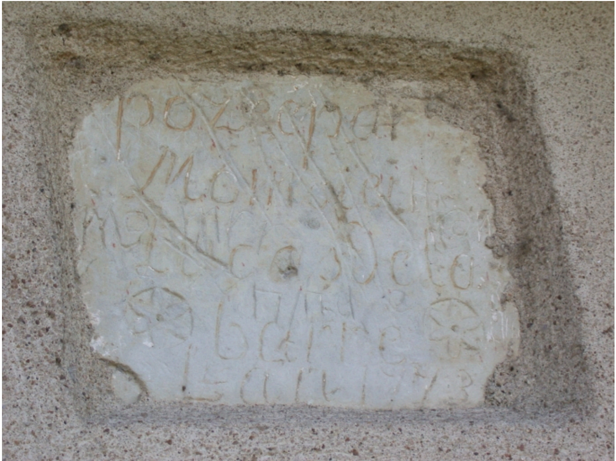
Façade sud, détail pierre de dédicace
