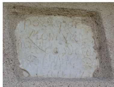
Façade sud, détail pierre de dédicace Phot. Véronique Orain IVR53_20023517308NUCA
