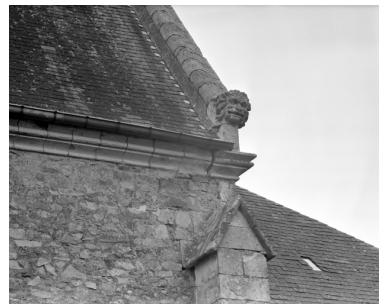
Elévation Ouest, pignon Sud, tête de lion : vue générale Phot. Bernard Bègne, Phot. M. Loyon IVR53_19933500424X
