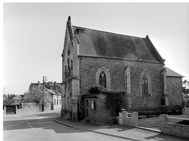
Elévation Ouest : vue générale Phot. Bernard Bègne, Phot. M. Loyon IVR53_19933500171X
