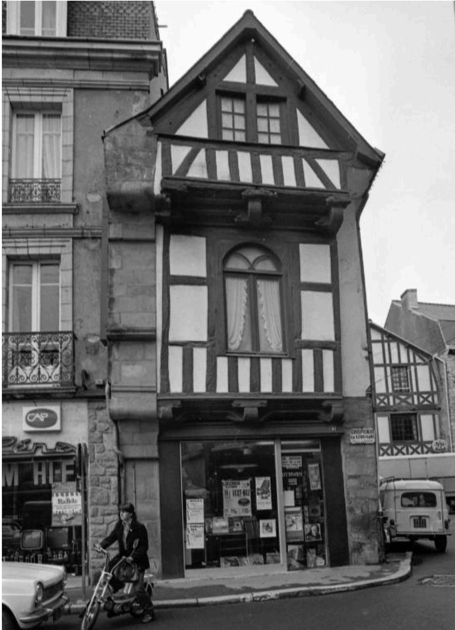
Au 20e siècle, l'enduit est ôté et laisse le pan de bois apparent.
