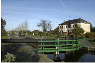
Vue sud-est Phot. Norbert Lambart IVR53_20053503040NUCA
