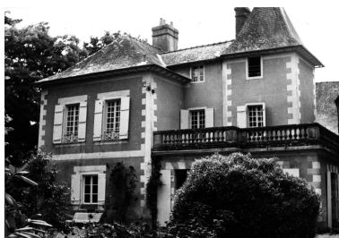
Façade antérieure du logis Repro. Guy Artur, Repro. Norbert Lambart IVR53_20013503305X
