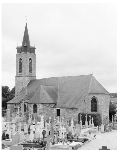
Vue sud-est Phot. Guy Artur, Phot. Norbert Lambart IVR53_19915600542X
