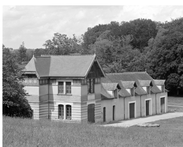
Vue générale des communs. Phot. Guy Artur, Phot. Norbert Lambart IVR53_19973502112X
