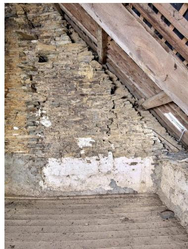
Logis. Etage. Emplacement de l'escalier en vis en demi hors-oeuvre ; à droite poutre avec les mortaises d'une cloison disparue ; à gauche cloison en bois tardive
