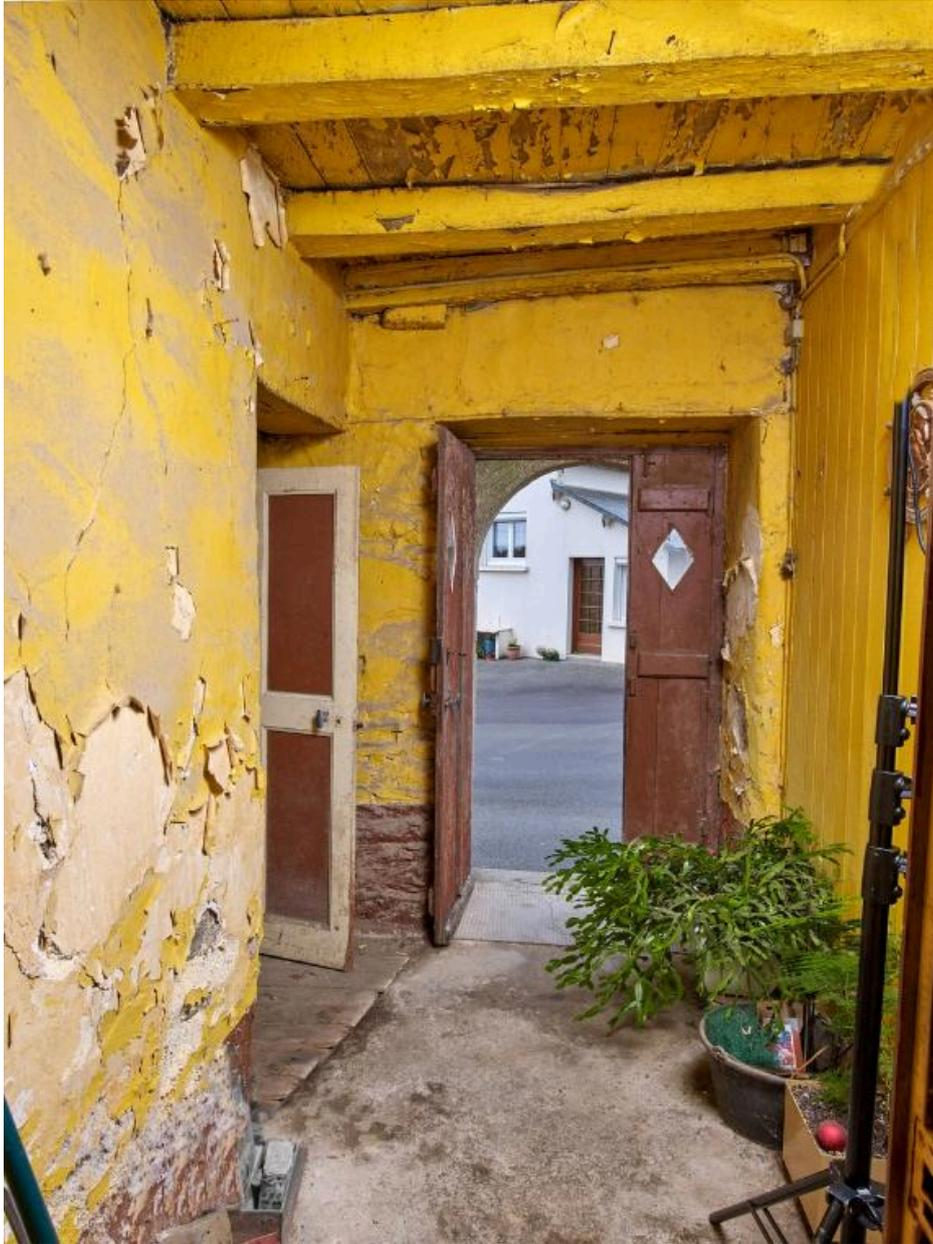
Logis. Rez-de-chaussée. Entrée ouest ouvrant à l'origine directement dans la salle, avant l'installation d'une cloison en bois
