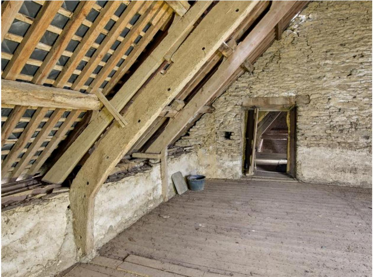
Logis. Grenier. Porte de communication dans le mur de refend, et charpente d'origine modifiée (suppression du coyau)
