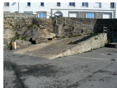
Escalier permettant d'accéder à la cale Cayenne
