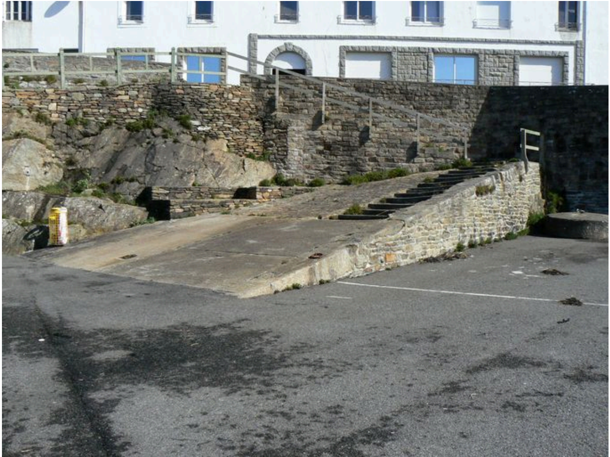
Escalier permettant d'accéder à la cale Cayenne
