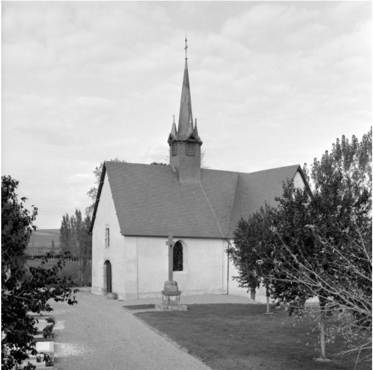
Elévation Sud-Ouest : vue générale
