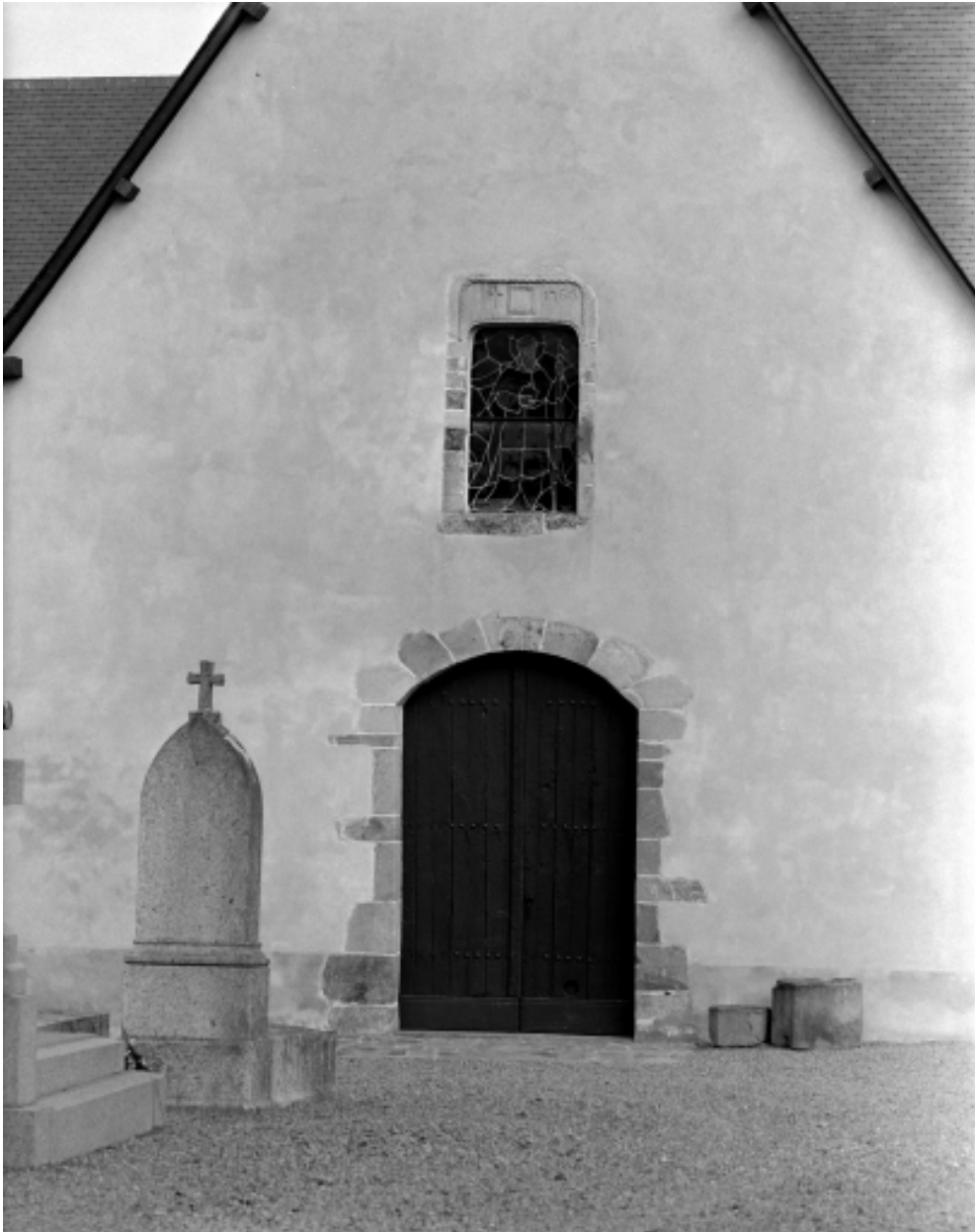
Elévation Ouest, porte : vue générale
