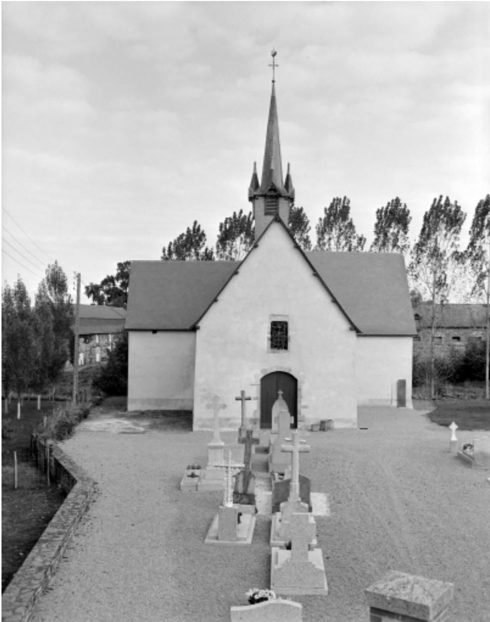
Elévation Ouest : vue générale
