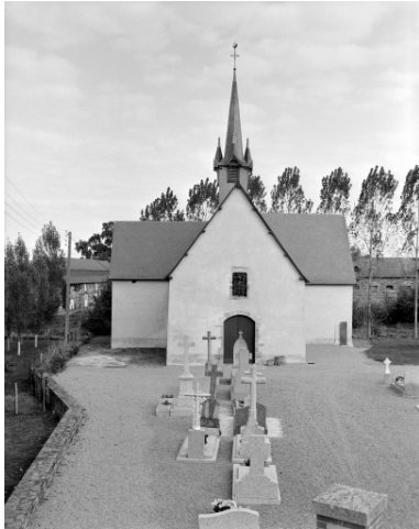
Elévation Ouest : vue générale Phot. Guy Artur, Phot. Norbert Lambart IVR53_19943501897X
