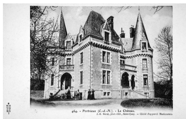
Elévations antérieure et latérale formant accès Phot. Elise Lauranceau IVR53_20042209033NUCB
