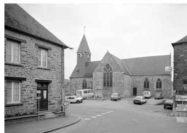
Elévation Sud : vue générale Phot. Guy Artur, Phot. Norbert Lambart IVR53_19933500662X
