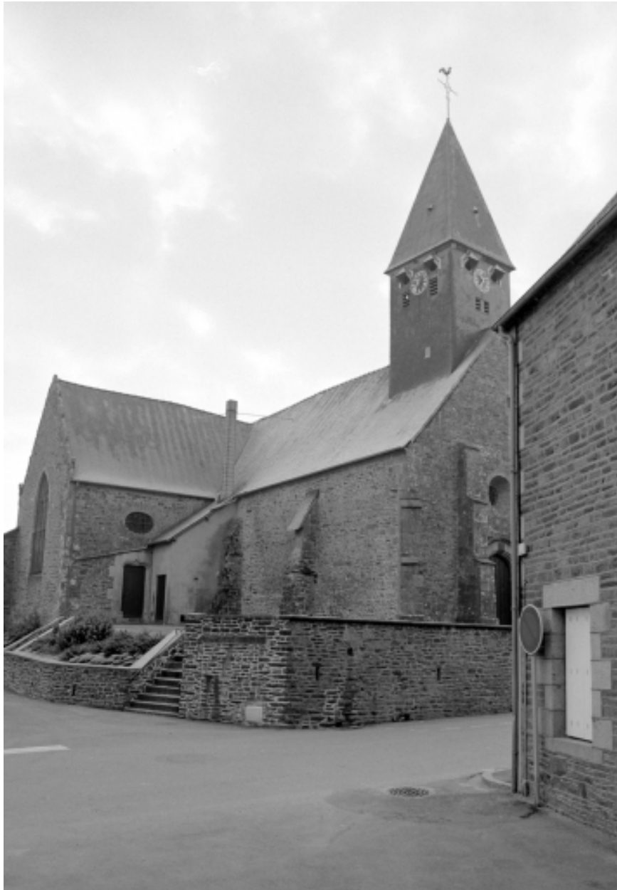
Elévation Nord-Ouest : vue générale
