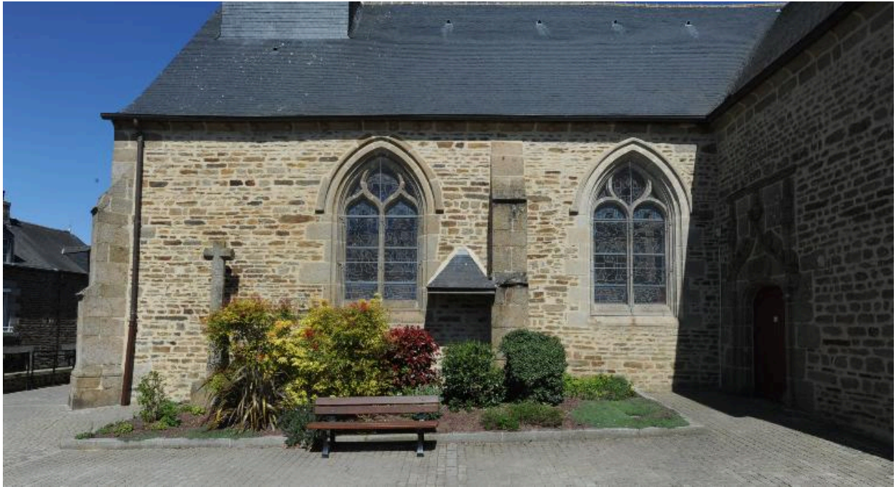
Nef : côté Sud
