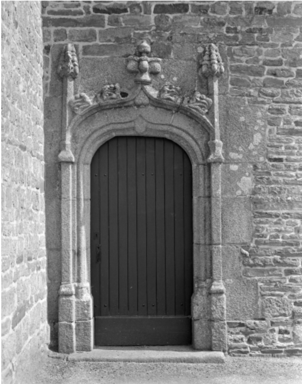
Elévation Sud, porte Est : vue générale
