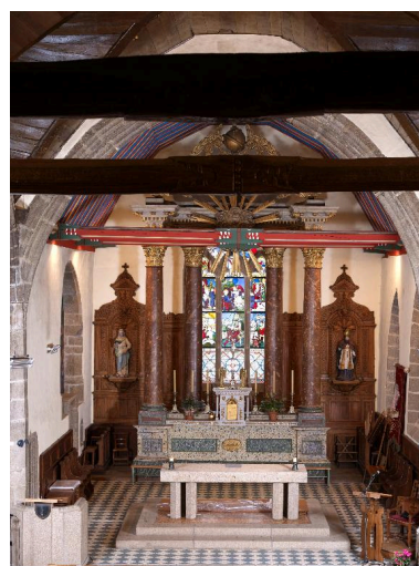
Choeur : vue générale Phot. Marine Michel IVR53_20133502094NUCA
