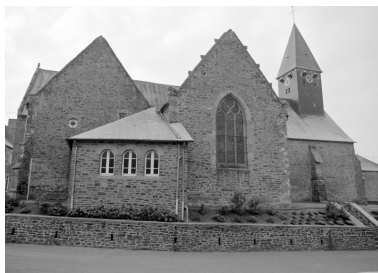
Elévation Nord : vue générale Phot. A. Bodén IVR53_19933500654X
