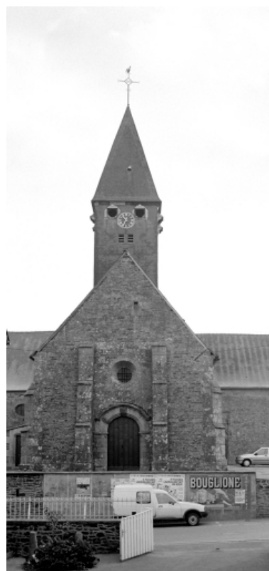
Elévation Ouest : vue générale Phot. A. Boden IVR53_19933500652X
