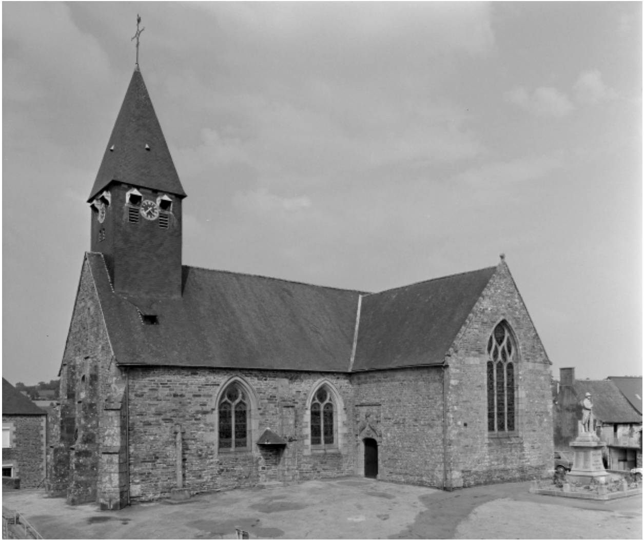
Elévation Sud-Ouest : vue générale
