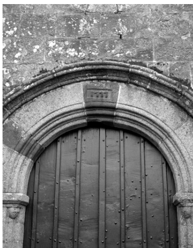
Elévation Ouest, porte datée : détail de l'inscription
