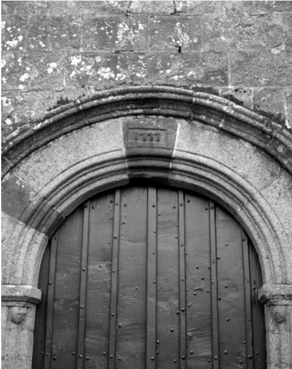
Elévation Ouest, porte datée : détail de l'inscription
