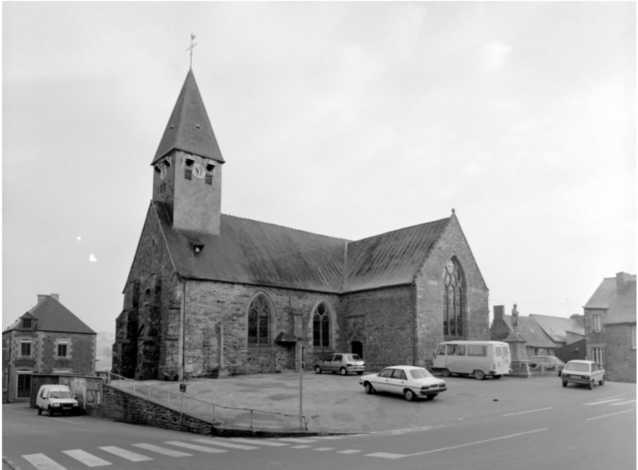
Elévation Sud-Ouest : vue générale
