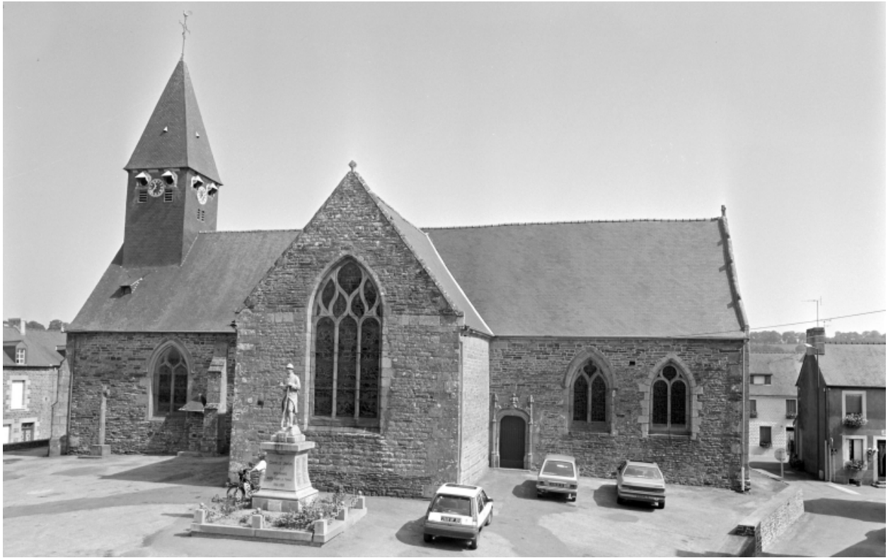
Elévation Sud : vue générale
