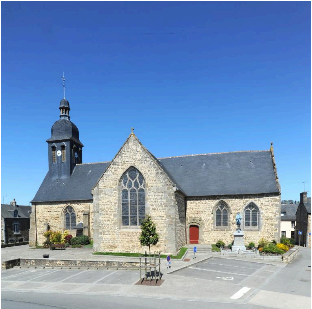
Vue générale : côté Sud
