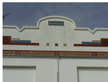
Fronton de la maison de villégiature Primerose Phot. Johan Vincent IVR53_20075605640NUCA
