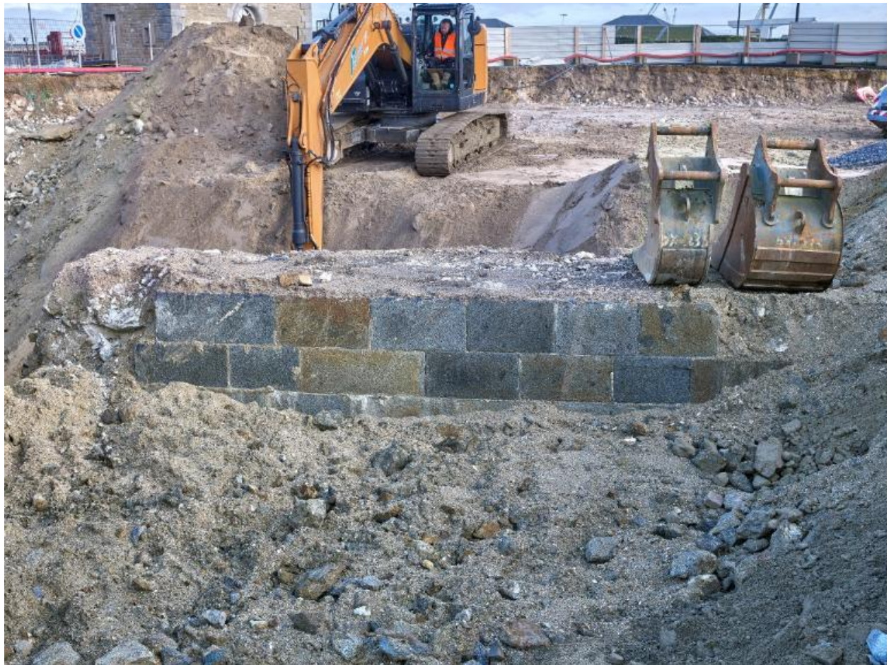
Vue des vestiges du quai de l'avant-port de Saint-Servan : élévation sud-ouest, maçonnerie en pierre de taille de granite (couverture photographique du 22 janvier 2026)
