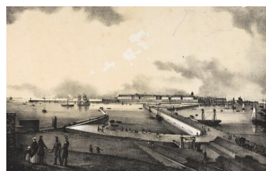
Vue de l'avant-port de Saint-Servan. Au premier plan, le fort du Naye (de gauche à droite : pièce d'artillerie dans son embrasure ; batardeau du fossé et sa dame ; fossé ; rampe ; pont-levis et banquette de tir). En arrière-plan, la ville de Saint-Malo Phot. Auteur inconnu, Autr. Hyacinthe Lorette IVR53_20263510094NUCA
