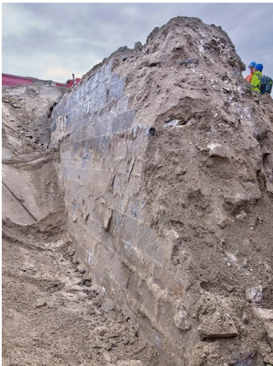
Vue des vestiges du quai de l'avant-port de Saint-Servan : maçonnerie en pierre de taille de granite (couverture photographique du 22 janvier 2026)
