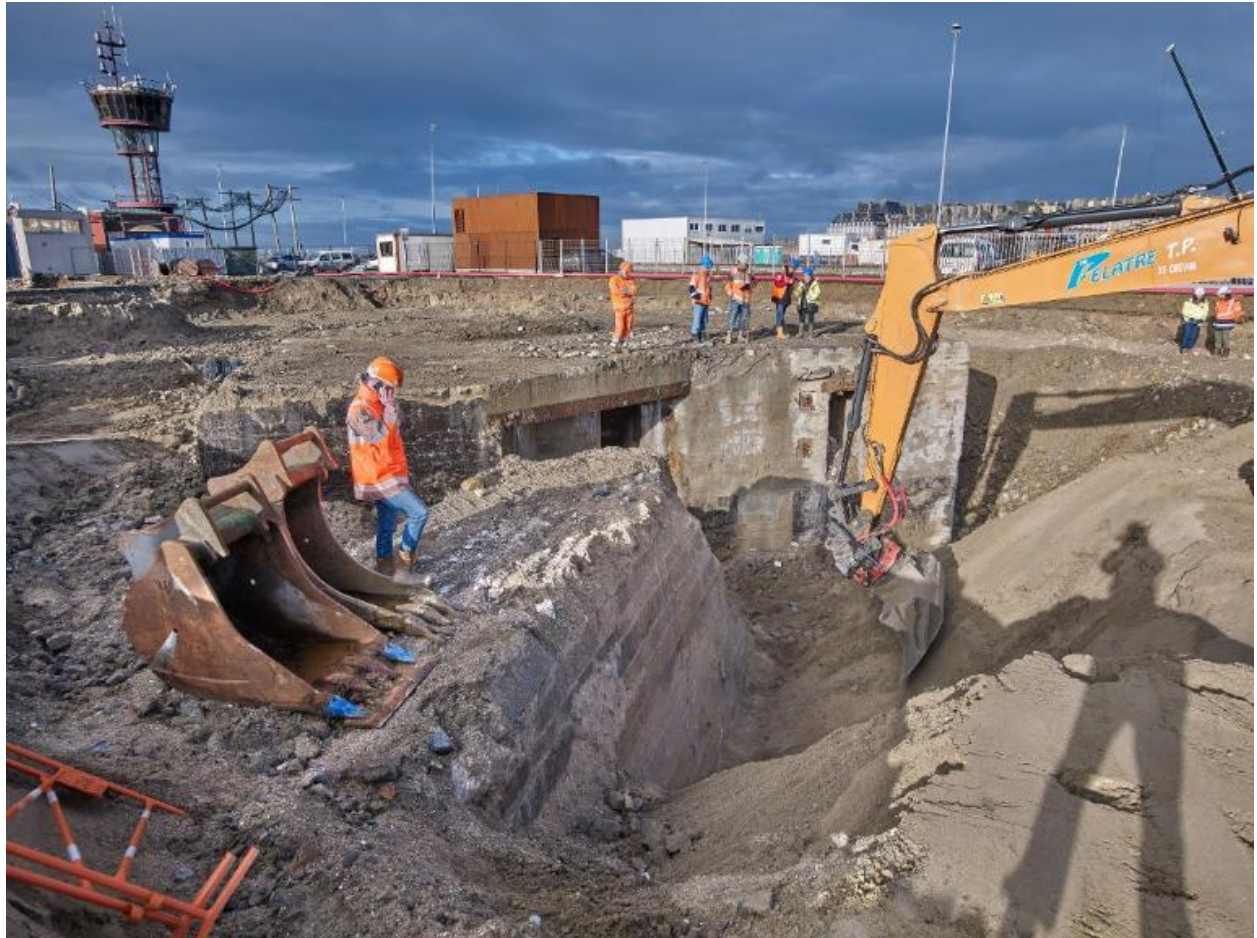
Vue des travaux d'excavation des vestiges du quai de l'avant-port de Saint-Servan avec une pelle hydraulique Case CX 245 D SR (couverture photographique du 22 janvier 2026). En arrière-plan à gauche, la vigie de la capitainerie du port de Saint-Malo
