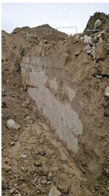
Vue des vestiges de l'avant-port de Saint-Servan : quai construit en maçonnerie de pierre de taille de granite (couverture photographique du 17 décembre 2025) Phot. Guillaume Lécueillier IVR53_20263510061NUCA
