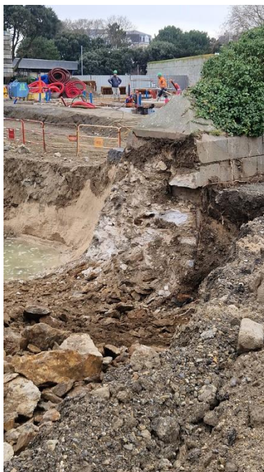
Vue des vestiges de l'avant-port de Saint-Servan : quai construit en maçonnerie de pierre de taille de granite (couverture photographique du 17 décembre 2025). En arrière-plan, le fort du Naye
