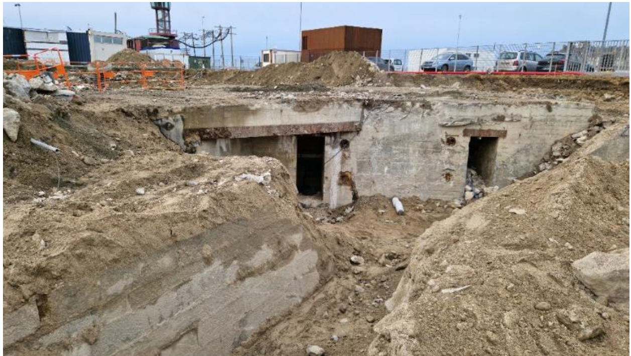
Vue des vestiges de l'avant-port de Saint-Servan : quai construit en maçonnerie de pierre de taille de granite (couverture photographique du 17 décembre 2025). En arrière-plan, le bunker de type L 401a
