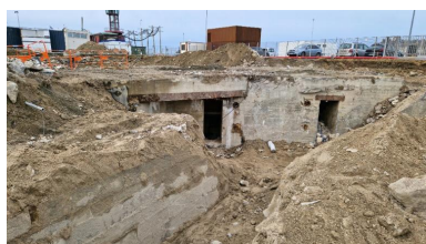
Vue des vestiges de l'avant-port de Saint-Servan : quai construit en maçonnerie de pierre de taille de granite (couverture photographique du 17 décembre 2025). En arrière-plan, le bunker de type L 401a Phot. Guillaume Lécueillier IVR53_20263510056NUCA
