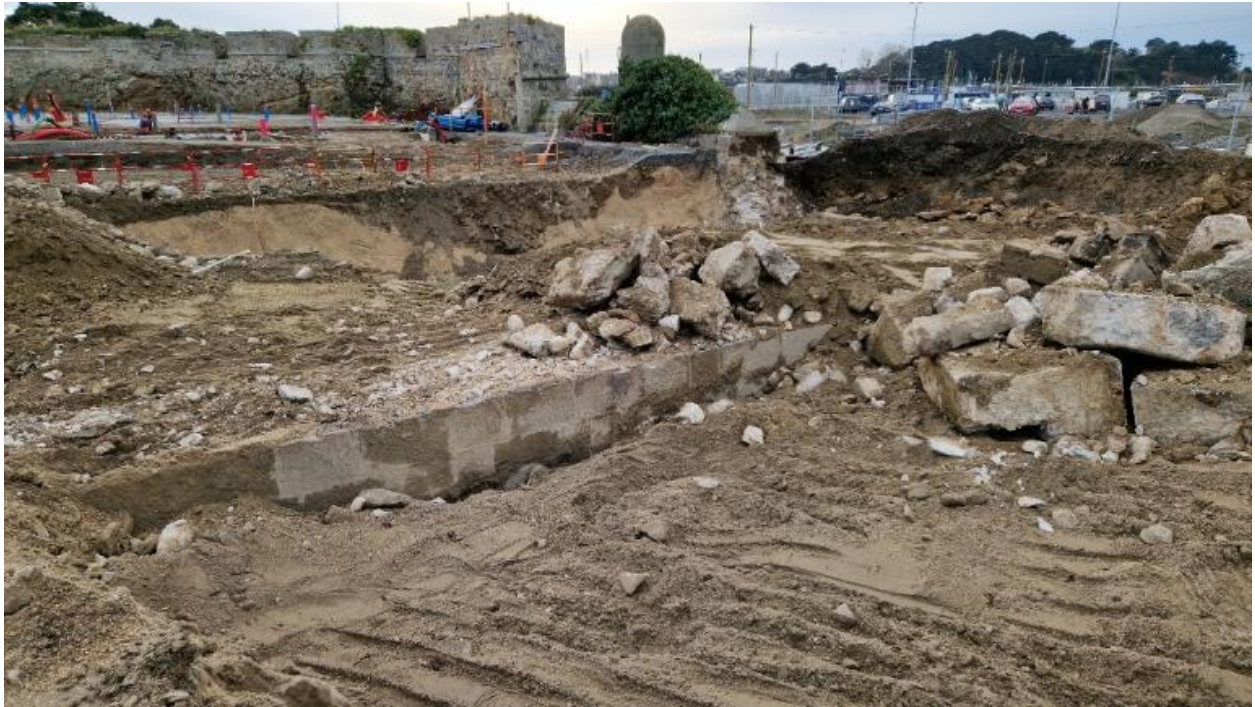
Vue des vestiges de l'avant-port de Saint-Servan : quai construit en maçonnerie de pierre de taille de granite (couverture photographique du 17 décembre 2025). En arrière-plan, le fort du Naye
