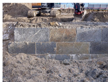
Vue de détail des vestiges du quai de l'avant-port de Saint-Servan : élévation sud-ouest, maçonnerie en pierre de taille de granite (couverture photographique du 22 janvier 2026)
