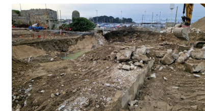
Vue des vestiges de l'avant-port de Saint-Servan : quai construit en maçonnerie de pierre de taille de granite (couverture photographique du 17 décembre 2025). En arrière-plan, le fort du Naye
