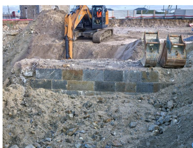
Vue des vestiges du quai de l'avant-port de Saint-Servan : élévation sud-ouest, maçonnerie en pierre de taille de granite (couverture photographique du 22 janvier 2026)
