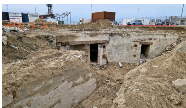
Vue des vestiges de l'avant-port de Saint-Servan : digue construite en maçonnerie de pierre de taille de granite (couverture photographique du 17 décembre 2025). En arrière-plan, le bunker de type L 401a Phot. Guillaume Lécueillier IVR53_20263510056NUCA
