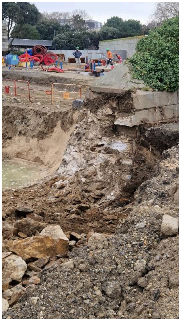
Vue de l'extrémité nord du batardeau du fossé du fort du Naye (couverture photographique du 17 décembre 2025). Cette partie du fort, montée en maçonnerie de pierre de taille de granite, était en connexion avec l'avant-port de Saint-Servan
