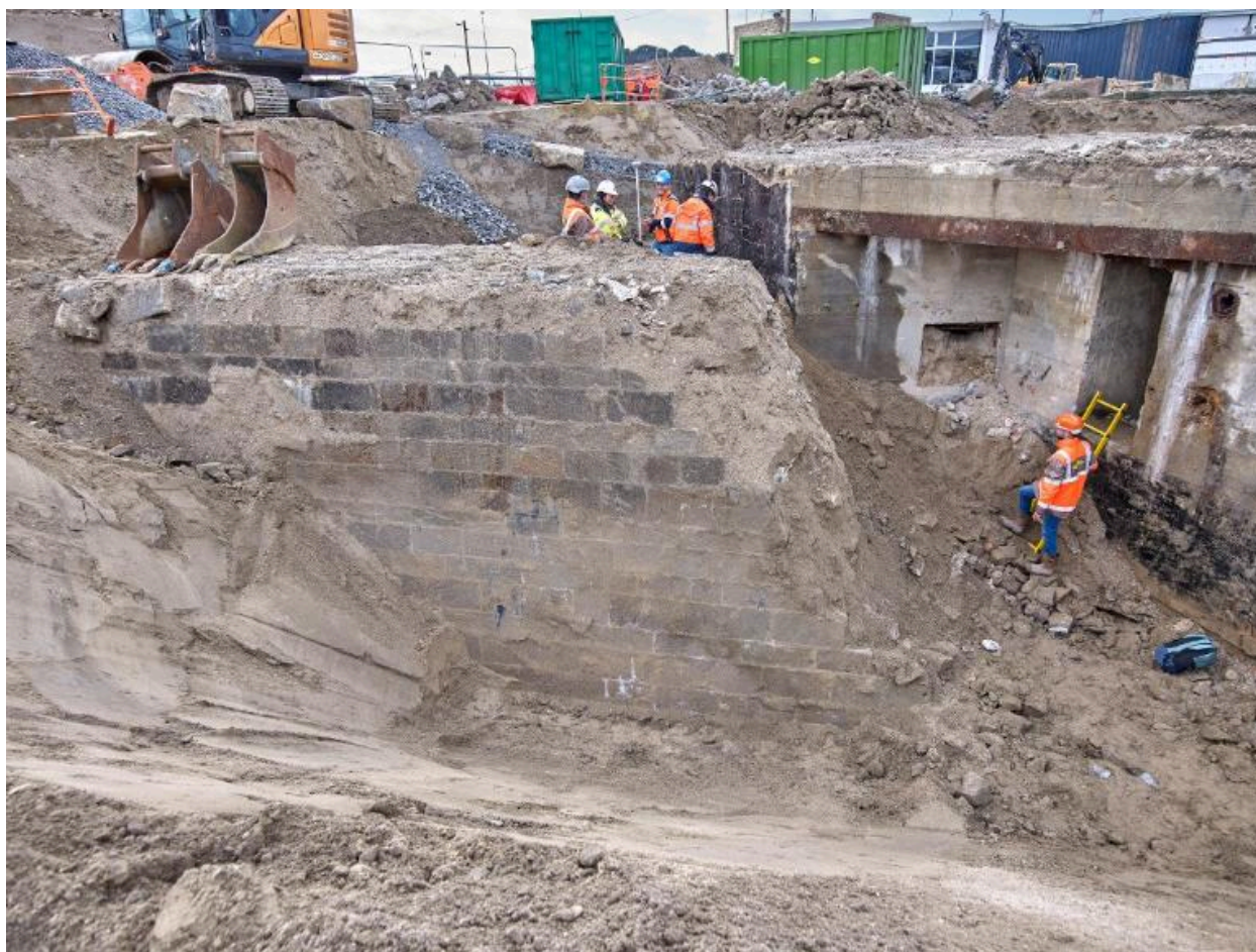
Vue des vestiges de la digue de l'avant-port de Saint-Servan et du bunker-abri-magasin de munitions de type L 401a avec cuve pour canon antiaérien (couverture photographique du 22 janvier 2026)
