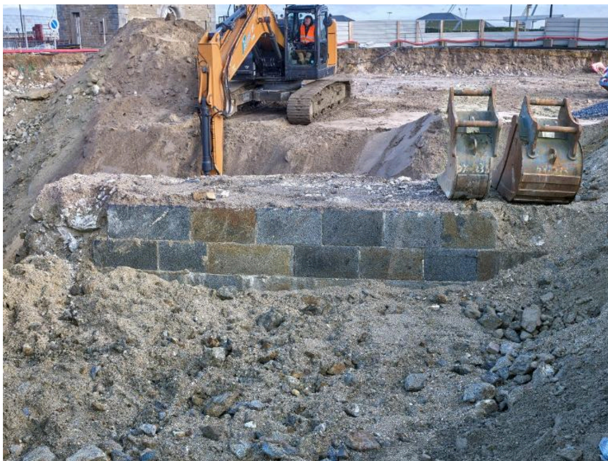
Vue des vestiges de la digue de l'avant-port de Saint-Servan : élévation sud-ouest, maçonnerie en pierre de taille de granite (couverture photographique du 22 janvier 2026)
