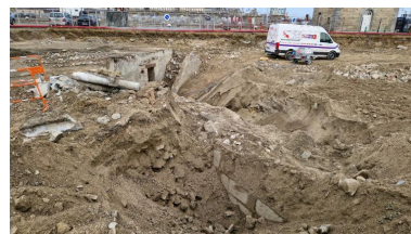
Au premier plan, vue des vestiges de l'avant-port de Saint-Servan : digue orientée vers le nord-ouest construit en maçonnerie de pierre de taille de granite (couverture photographique du 17 décembre 2025). En arrière-plan, le bunker de type L 401a Phot. Guillaume Lécueillier IVR53_20263510059NUCA
