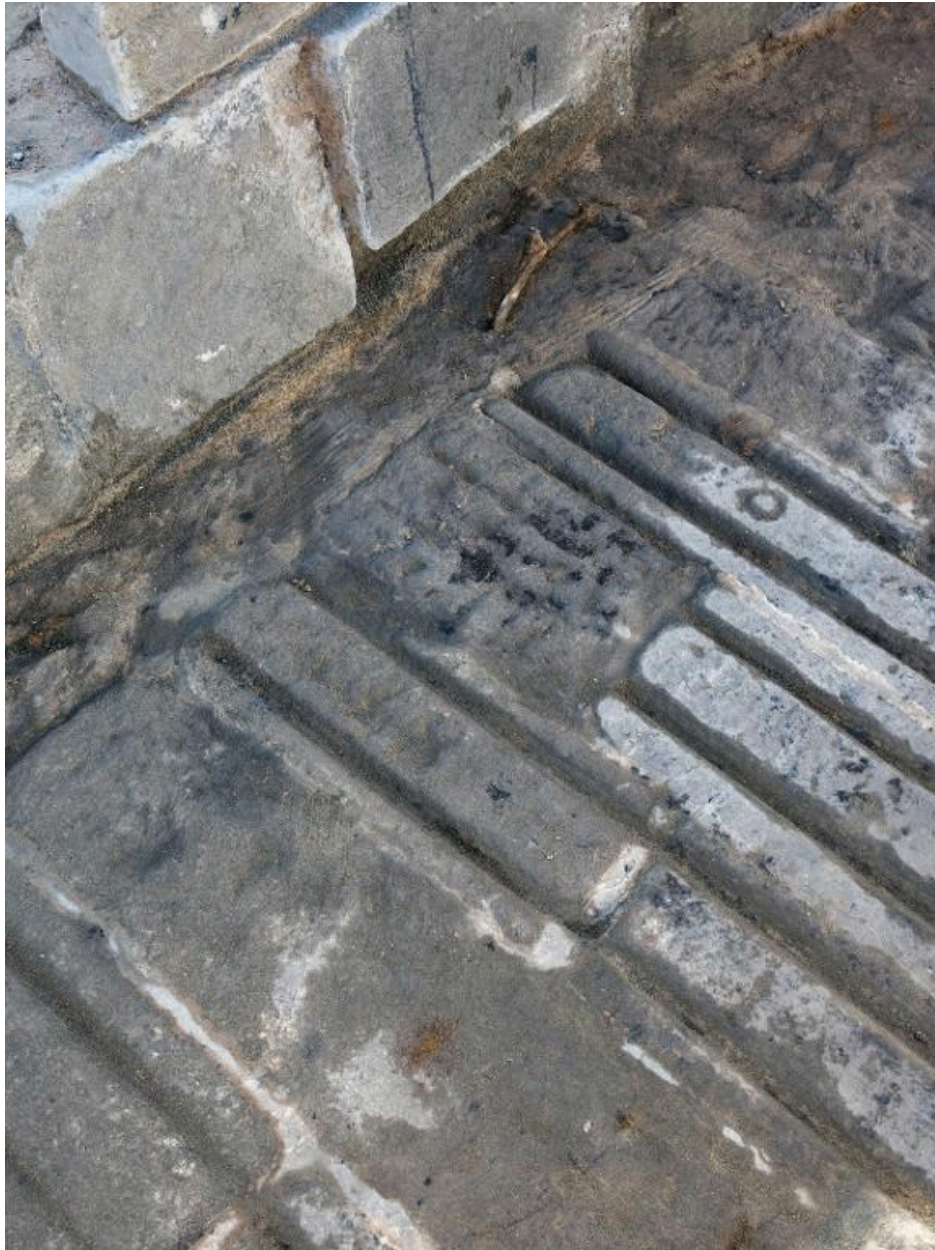
Vue de l'opération archéologique réalisée sous la responsabilité de Ronan Louessard - INRAP avec un suivi scientifique et technique du DRASSM (couverture photographique du 11 mars 2026). Détail du dallage de la cale
