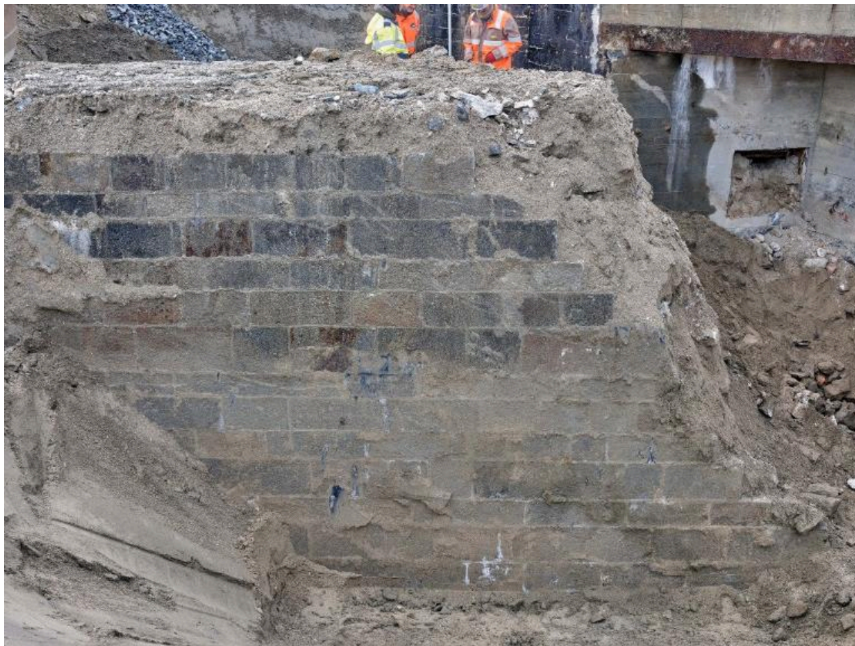
Vue des vestiges de la digue de l'avant-port de Saint-Servan : élévation nord-est, maçonnerie en pierre de taille de granite (couverture photographique du 22 janvier 2026)
