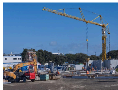
Vue du chantier du terre-plein du Naye (couverture photographique du 11 mars 2026) Phot. Bernard Bègne IVR53_20263500564NUCA
