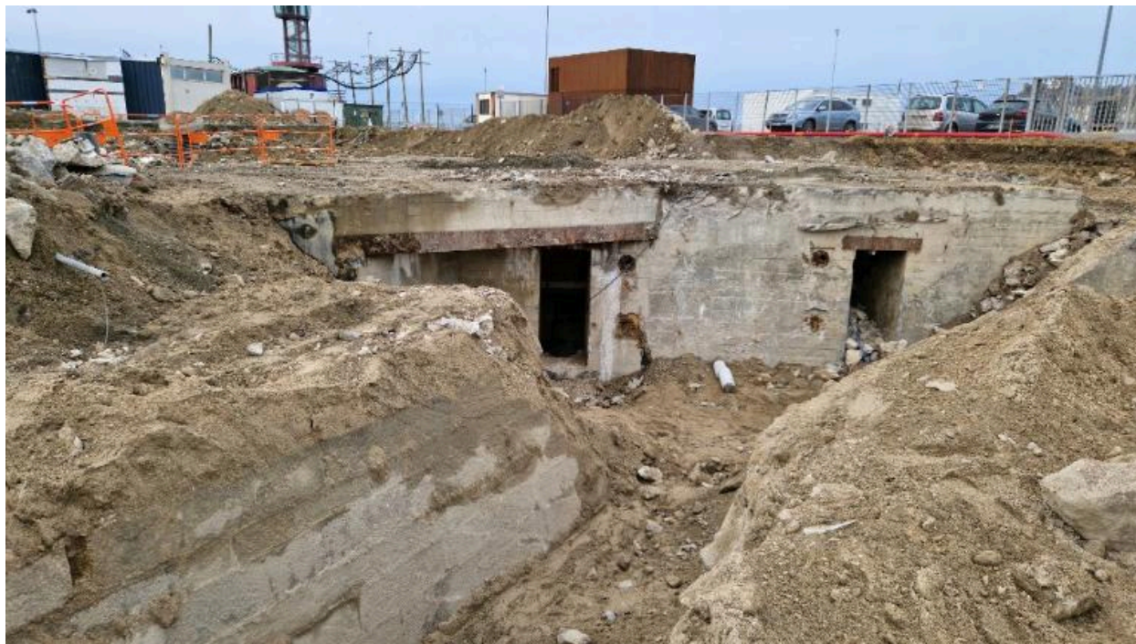
Vue des vestiges de l'avant-port de Saint-Servan : digue construite en maçonnerie de pierre de taille de granite (couverture photographique du 17 décembre 2025). En arrière-plan, le bunker de type L 401a
