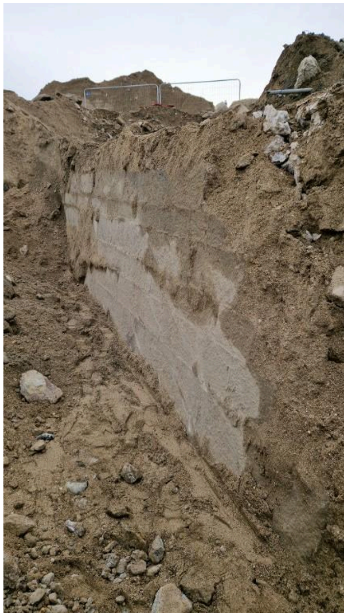
Vue des vestiges de l'avant-port de Saint-Servan : digue construite en maçonnerie de pierre de taille de granite (couverture photographique du 17 décembre 2025)
