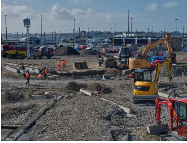
Vue du chantier du terre-plein du Naye (couverture photographique du 11 mars 2026) Phot. Bernard Bègne IVR53_20263500552NUCA
