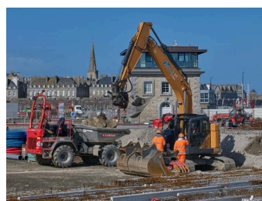
Vue du chantier du terre-plein du Naye (couverture photographique du 11 mars 2026) Phot. Bernard Bègne IVR53_20263500559NUCA
