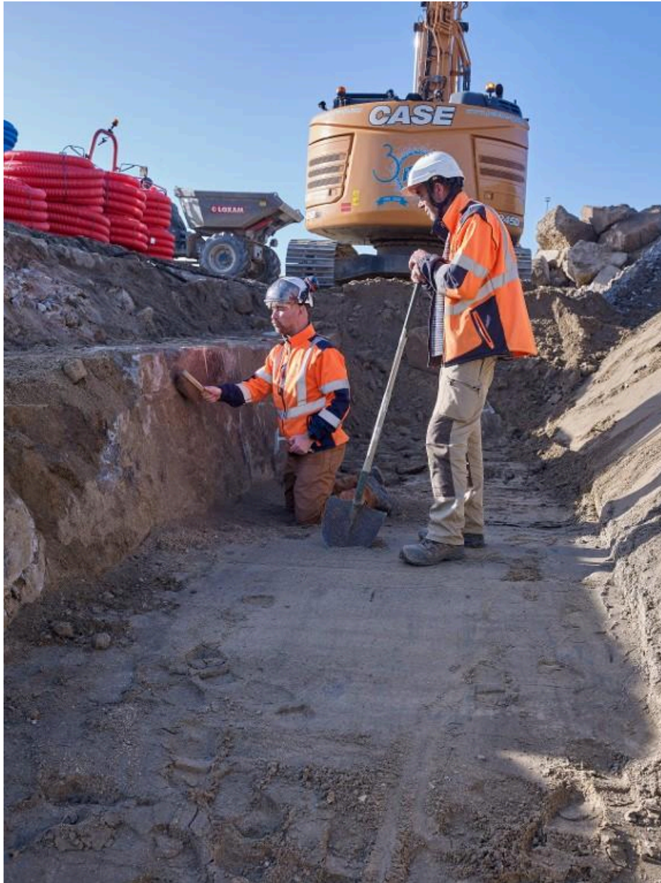
Vue de l'opération archéologique réalisée sous la responsabilité de Ronan Louessard - INRAP avec un suivi scientifique et technique du DRASSM (couverture photographique du 11 mars 2026)
