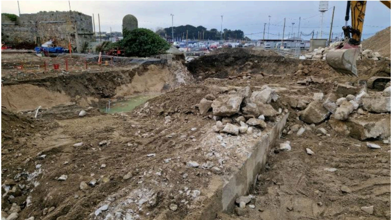
Vue des vestiges de l'avant-port de Saint-Servan : embarcadère construit en maçonnerie de pierre de taille de granite (couverture photographique du 17 décembre 2025). En arrière-plan, le fort du Naye
