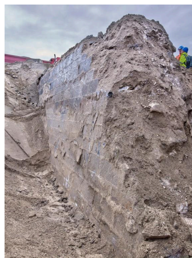
Vue des vestiges de la digue de l'avant-port de Saint-Servan : maçonnerie en pierre de taille de granite (couverture photographique du 22 janvier 2026) Phot. Bernard Bègne IVR53_20263500107NUCA
