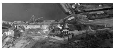
Vue aérienne oblique depuis l'ouest-sud-ouest montrant le chantier de construction de la grande écluse du Naye, 27 septembre 1929. Sur la photographie, on voit notamment l'avant-port de Saint-Servan en cours de remblaiement et le fort du Naye Repro. Institut national de l'information géographique et forestière, Autr. Auteur inconnu
