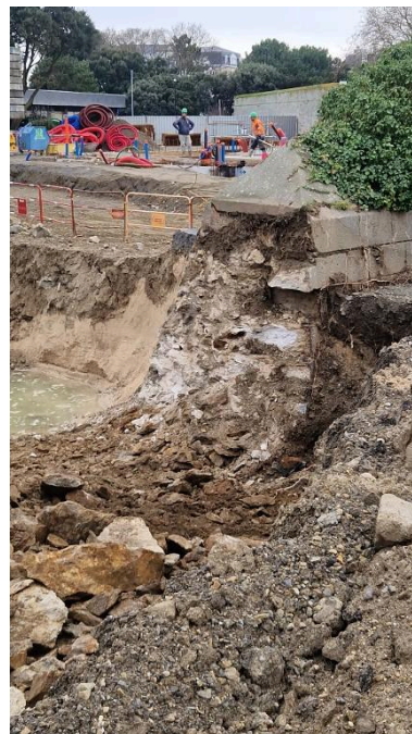
Vue de l'extrémité nord du batardeau du fossé du fort du Naye (couverture photographique du 17 décembre 2025). Cette partie du fort, montée en maçonnerie de pierre de taille de granite, était en connexion avec l'avant-port de Saint-Servan Phot. Guillaume Lécueillier IVR53_20263510085NUCA
