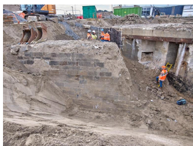
Vue des vestiges de la digue de l'avant-port de Saint-Servan et du bunker-abri-magasin de munitions de type L 401a avec cuve pour canon antiaérien (couverture photographique du 22 janvier 2026) Phot. Bernard Bègne IVR53_20263500111NUCA
