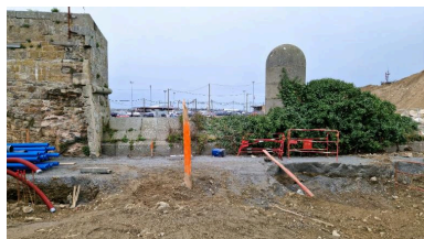
Vue du batardeau et de la dame du fossé du fort du Naye depuis l'est (couverture photographique du 17 décembre 2025). Cette partie du fort, montée en maçonnerie de pierre de taille de granite, était en connexion avec l'avant-port de Saint-Servan Phot. Guillaume Lécueillier IVR53_20263510089NUCA
