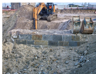
Vue des vestiges de la digue de l'avant-port de Saint-Servan : élévation sud-ouest, maçonnerie en pierre de taille de granite (couverture photographique du 22 janvier 2026) Phot. Bernard Bègne IVR53_20263500103NUCA
