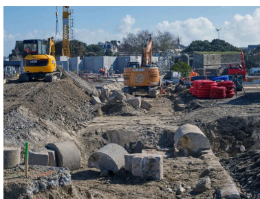
Vue de l'opération archéologique réalisée sous la responsabilité de Ronan Louessard - INRAP avec un suivi scientifique et technique du DRASSM (couverture photographique du 11 mars 2026). Certains chaperons de la digue ont été retrouvés en place ou en vrac Phot. Bernard Bègne IVR53_20263500604NUCA
