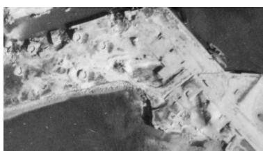
Vue aérienne verticale du fort du Naye et du terre-plein avec la batterie d'artillerie antiaérienne lourde le 13 août 1944 (export cartographique : Région Bretagne, Guillaume Lécueillier, 2026) Dess. Auteur inconnu IVR53_20263510418NUD
