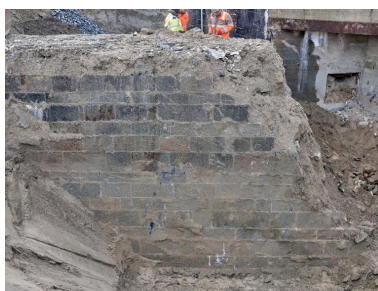
Vue des vestiges de la digue de l'avant-port de Saint-Servan : élévation nord-est, maçonnerie en pierre de taille de granite (couverture photographique du 22 janvier 2026) Phot. Bernard Bègne IVR53_20263500110NUCA
