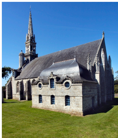
Vue générale prise du sud-est avec la sacristie au premier plan Phot. Norbert Lambart IVR53_20072900205NUCA
