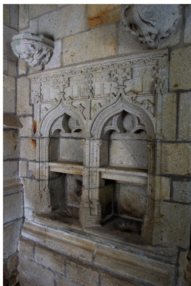
Vue intérieure, niches, crédences Phot. Norbert Lambart IVR53_20072900170NUCA
