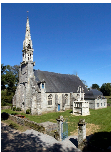
Vue générale prise du sud-ouest avec le calvaire et la sacristie en arrière-plan Phot. Norbert Lambert IVR53_20072900203NUCA
