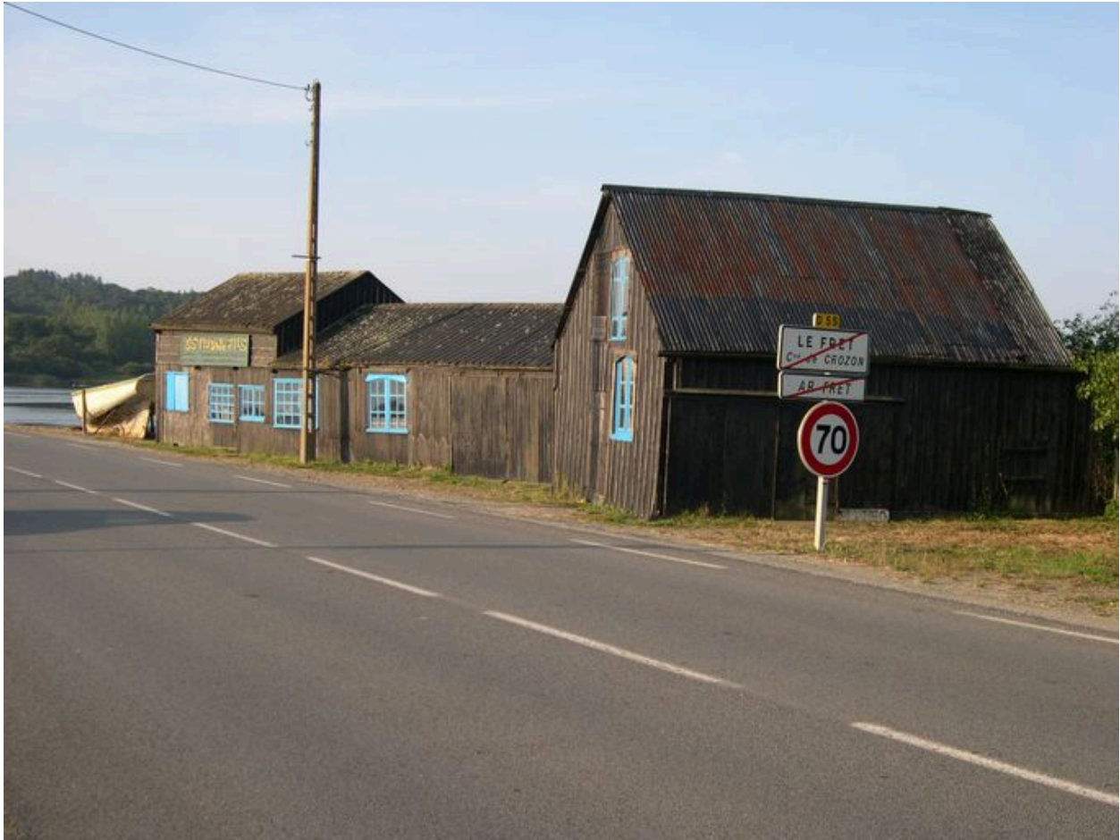
Vue générale de l'atelier de chantier naval Stipon
