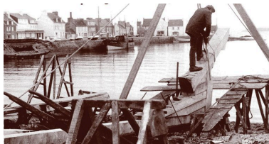
Le chantier Stipon en 1973 Repro. Florence Desprez IVR53_20072908855NUC
