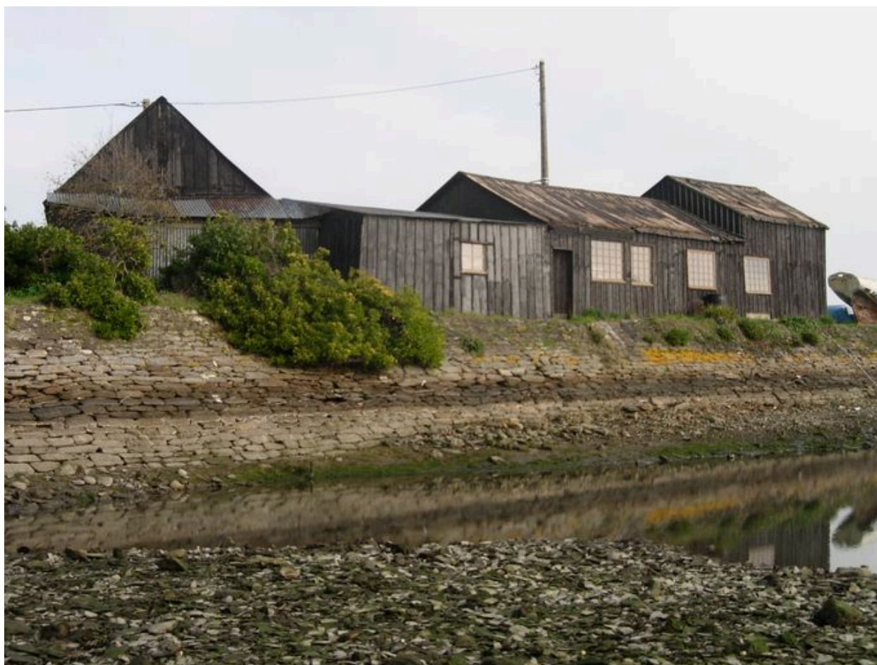
Vue arrière de l'atelier de chantier naval Stipon
