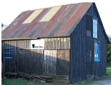
Cabane de l'atelier de chantier naval Stipon Phot. Françoise Péron IVR53_20062908515NUCA
