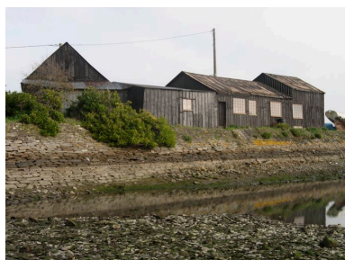
Vue arrière de l'atelier de chantier naval Stipon Phot. Guillaume Marie IVR53_20062908516NUCA
