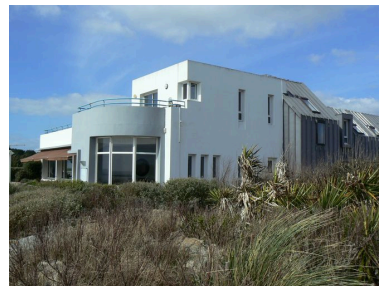
Hôtel-restaurant Les Mouettes Phot. Johan Vincent IVR53_20075605578NUCA
