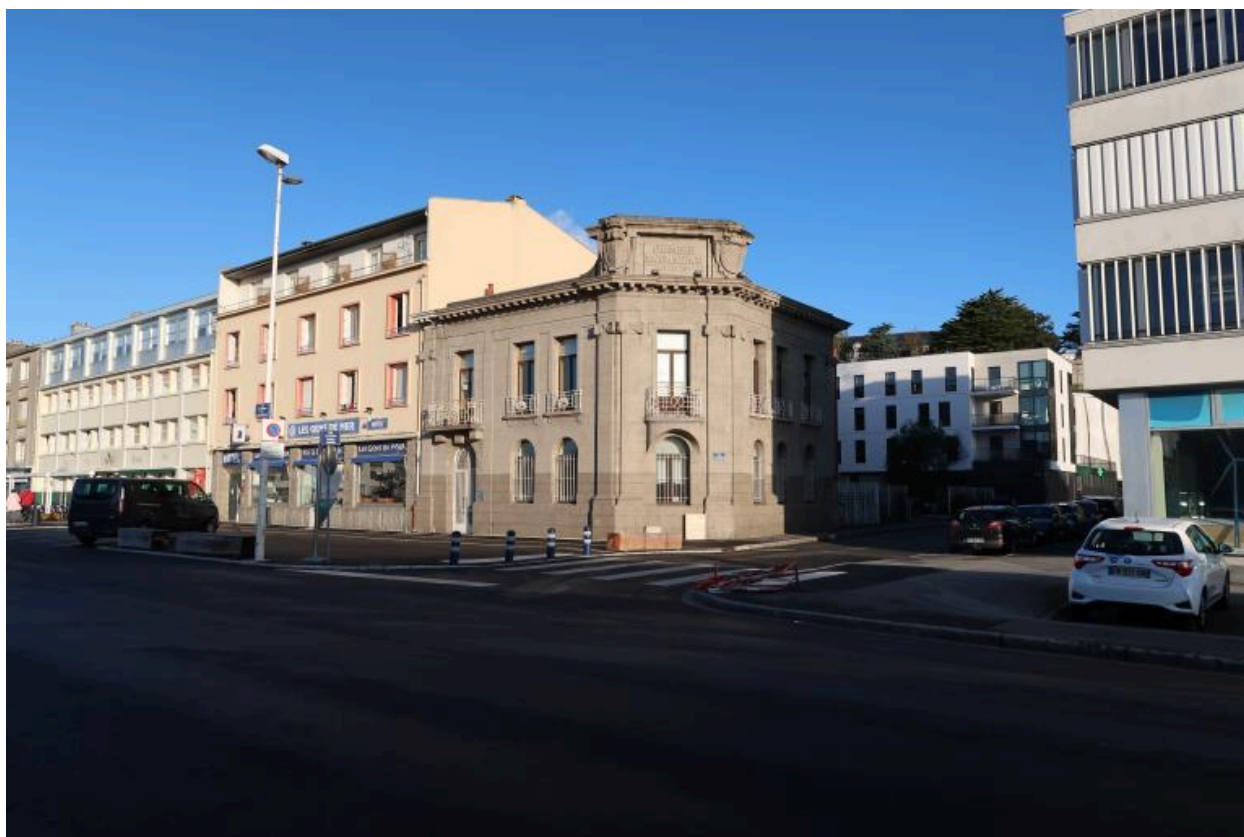
Chambre de commerce (1923) : vue générale, à l'angle du quai de la Douane et de la rue Bassam
