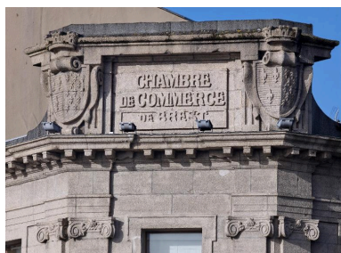
Fronton sommital de la façade de l'ancienne chambre de commerce : CHAMBRE DE COMMERCE DE BREST Phot. Bernard Bègne
