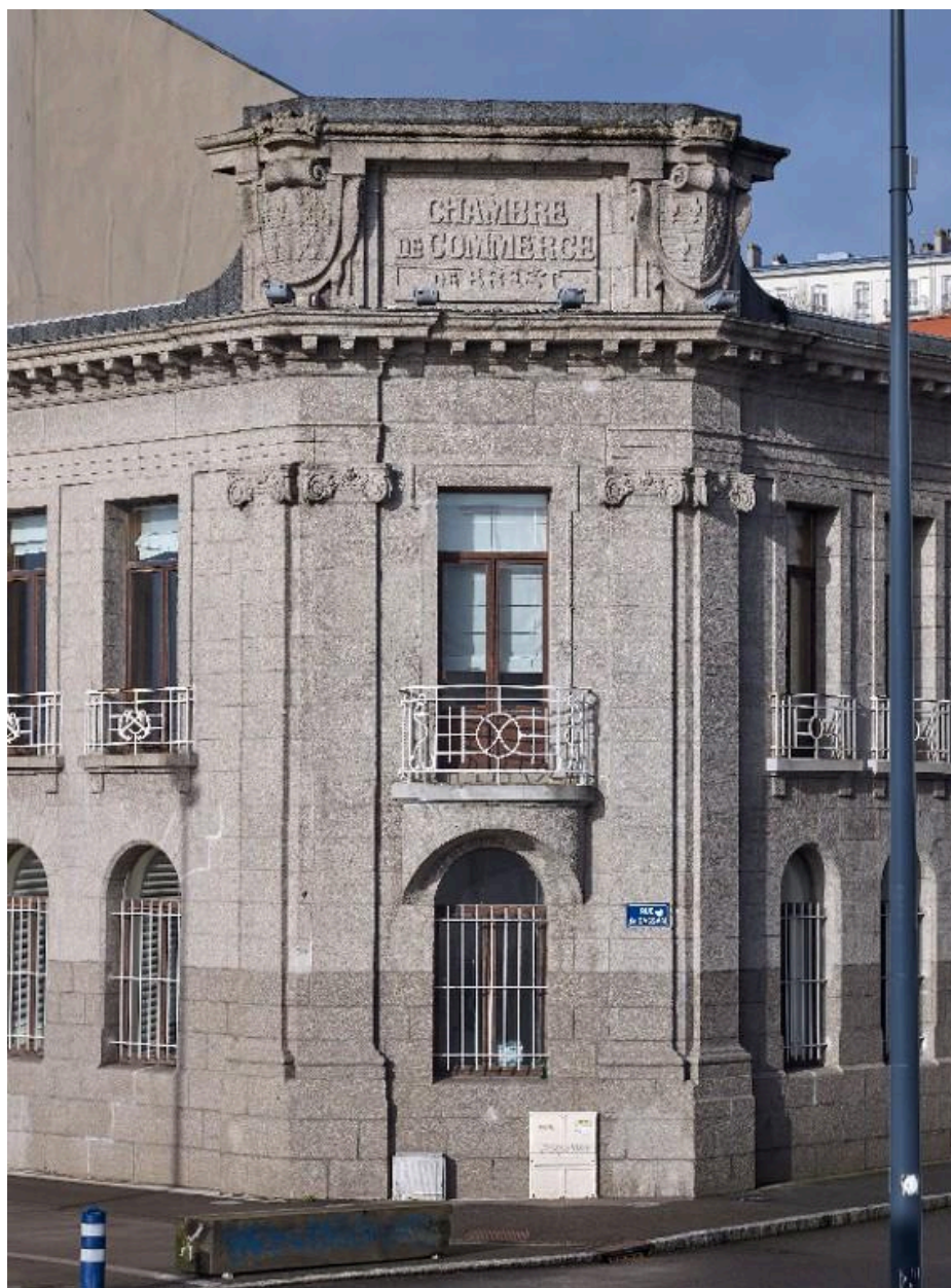
Façade de l'ancienne Chambre de commerce de Brest
