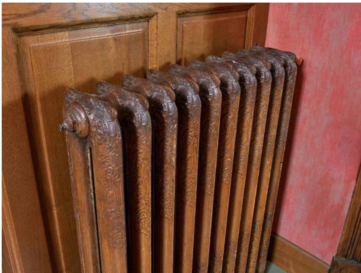
Radiateur en fonte du hall d'entrée (détail)
