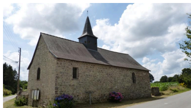
Vue générale nord-est en 2018 Phot. Laurence Marquet IVR53_20183506994NUCA
