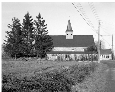
Vue générale sud en 2002 Phot. Bernard Bègne, Phot. M. Loyon IVR53_19933500049X
