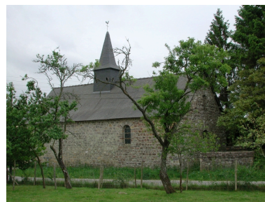
Vue générale nord-ouest Phot. Claude Quillivic IVR53_20023512762NUCA
