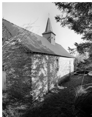
Vue partielle sud-ouest Phot. Bernard Bègne, Phot. M. Loyon IVR53_19933500050X
