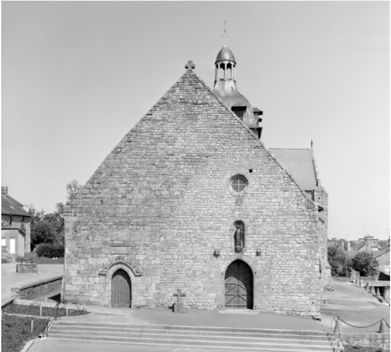
Elévation Ouest, porte principale : vue générale
