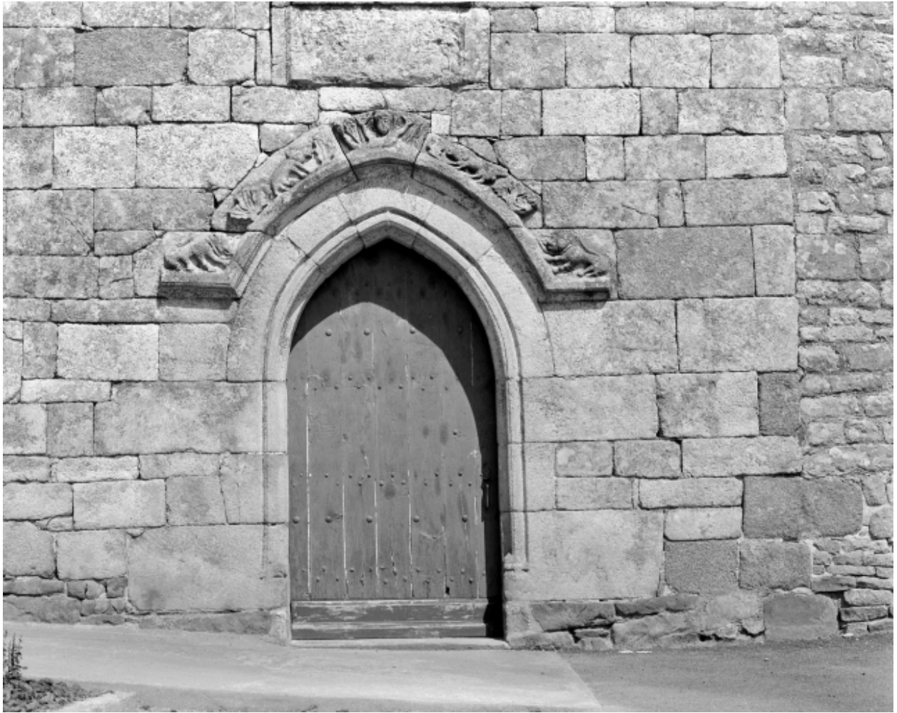
Elévation Ouest, porte : vue générale
