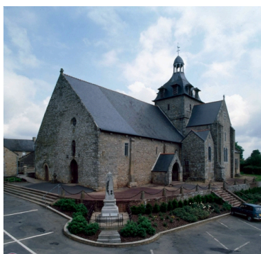
Elévation Sud-Ouest : vue générale Phot. Guy Artur, Phot. Norbert Lambart IVR53_19953500316XA
