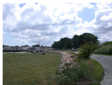
Vue des enrochements Phot. Guy Prigent IVR53_20092212435NUCA
