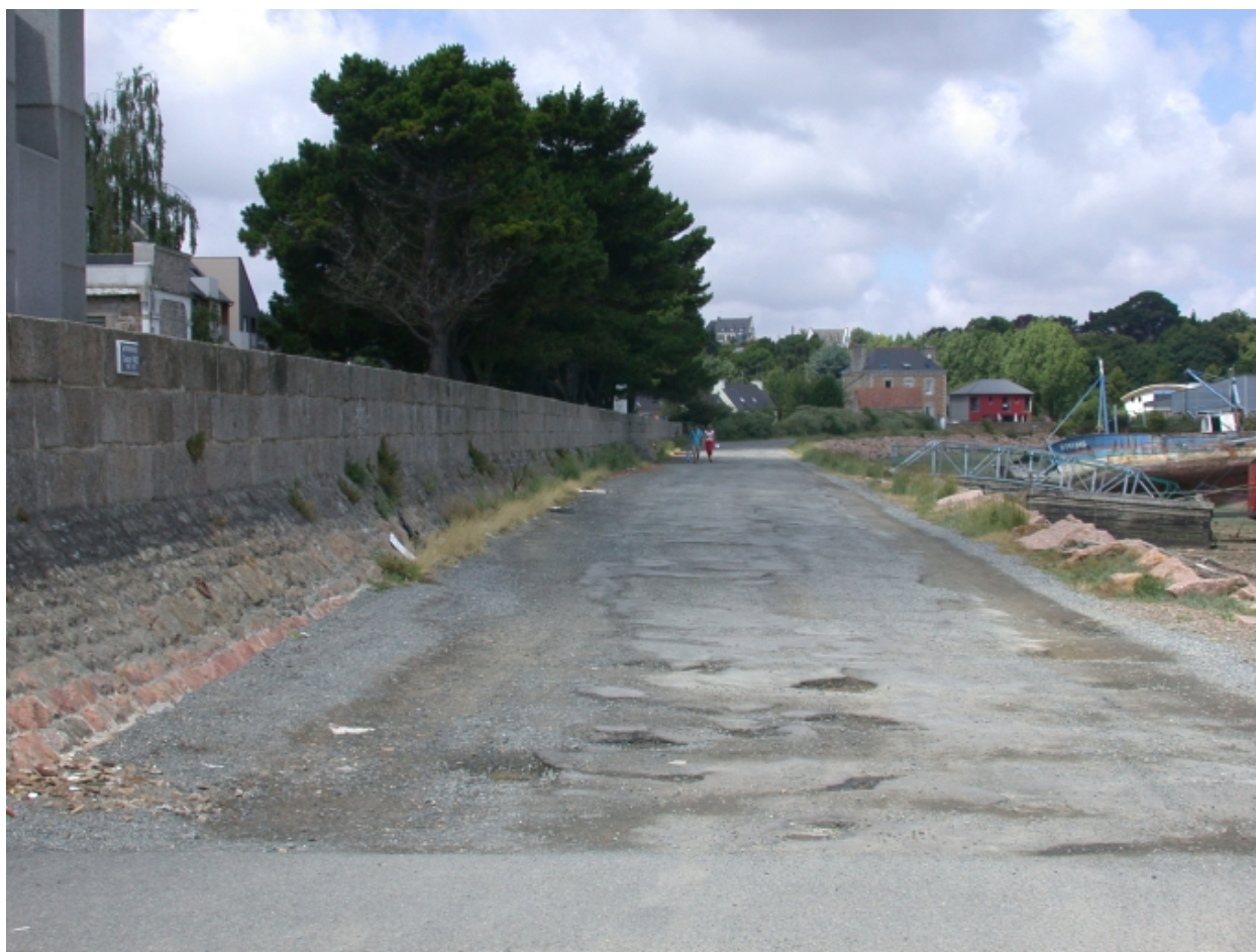
Vue de la promenade le long de la digue du Champ de Foire
