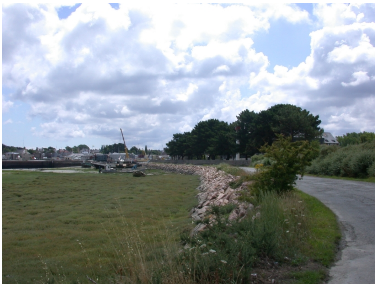
Vue des enrochements
