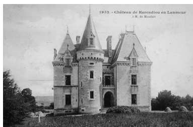
Vue générale Phot. Elise Lauranceau IVR53_20042905469NUCB
