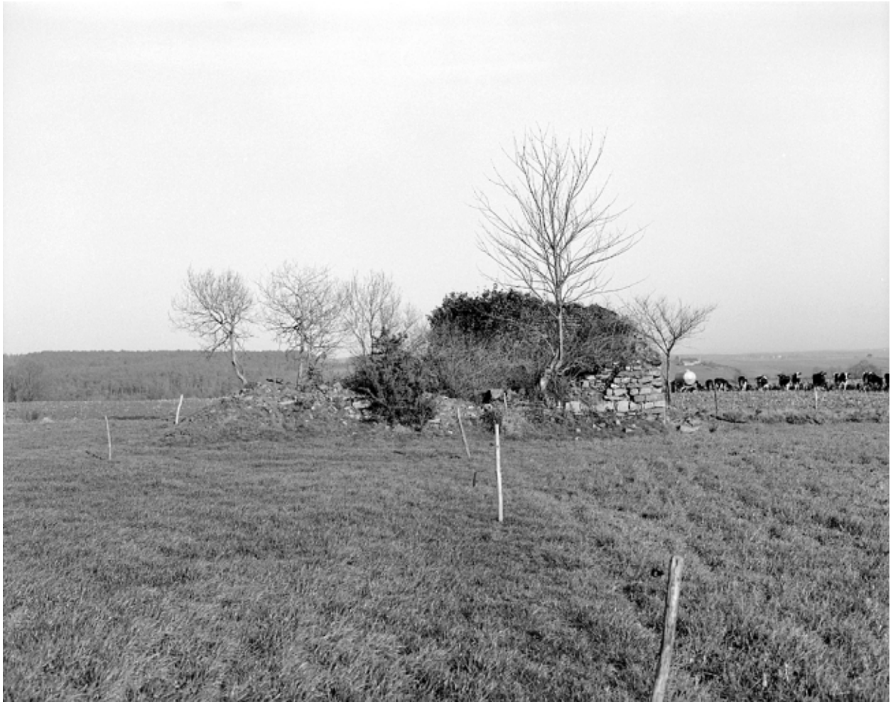
Elévation sud : vue de situation
