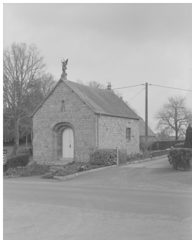
Elévation Sud-Ouest : vue générale Phot. Bernard Bègne, Phot. M. Loyon IVR53_19933500320X
