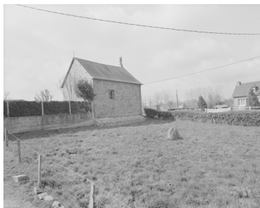
Elévation Nord-Est : vue générale Phot. Bernard Bègne, Phot. M. Loyon IVR53_19933500321X
