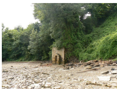
Fontaine de Quéléren sur la grève Phot. Lénäïg L'Aot IVR53_20072908963NUCA
