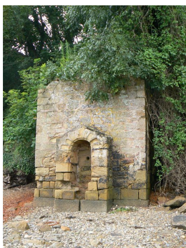
Vue générale de la fontaine de Quéléren Phot. Lénäïg L'Aot IVR53_20072908961NUCA
