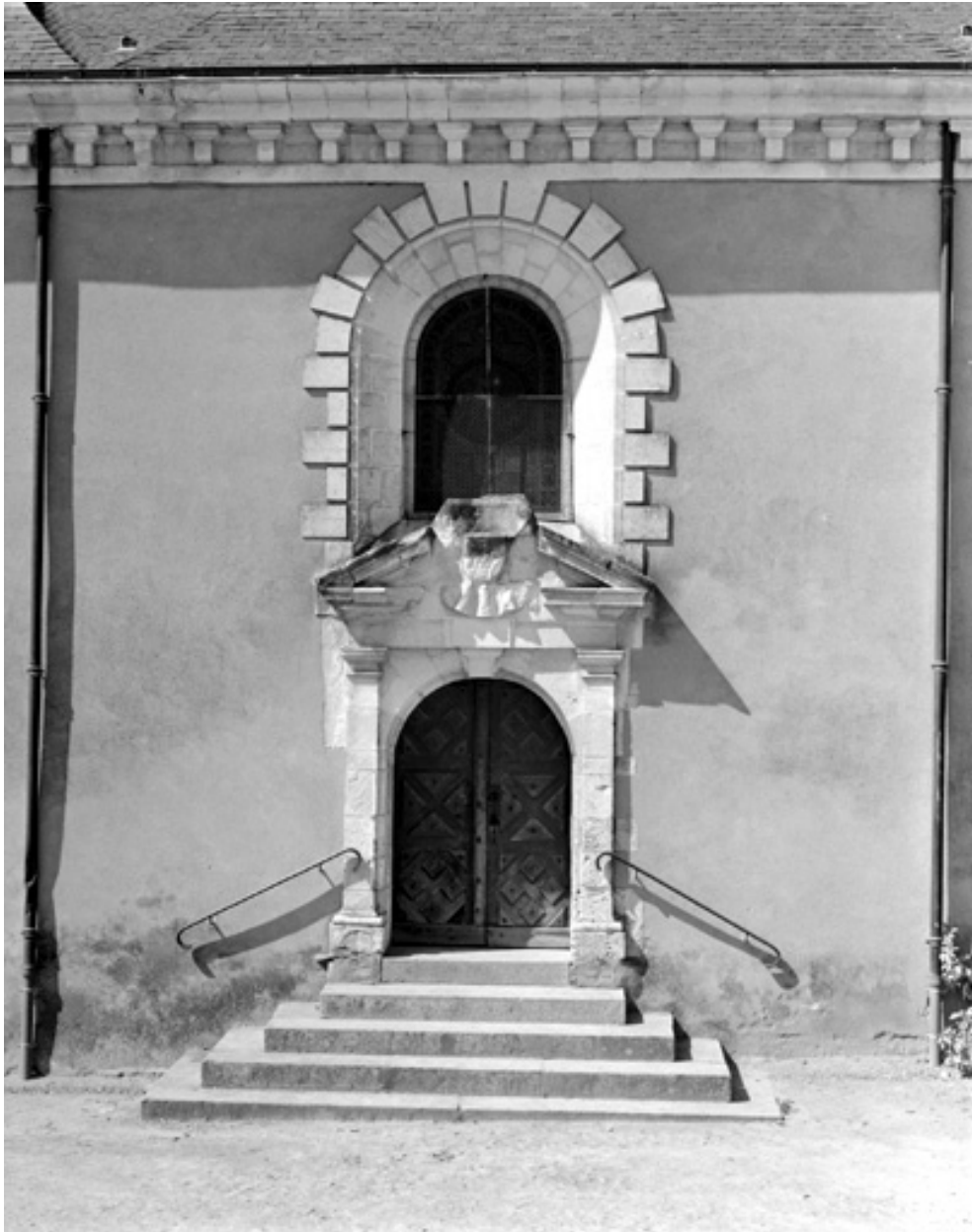
Elevation sud, porte
