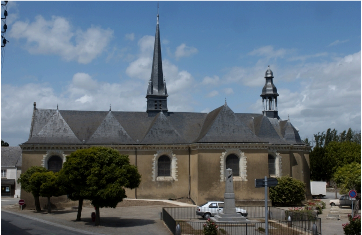
Vue générale sud de l'église
