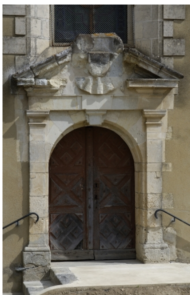
Porte sud de l'église paroissiale
