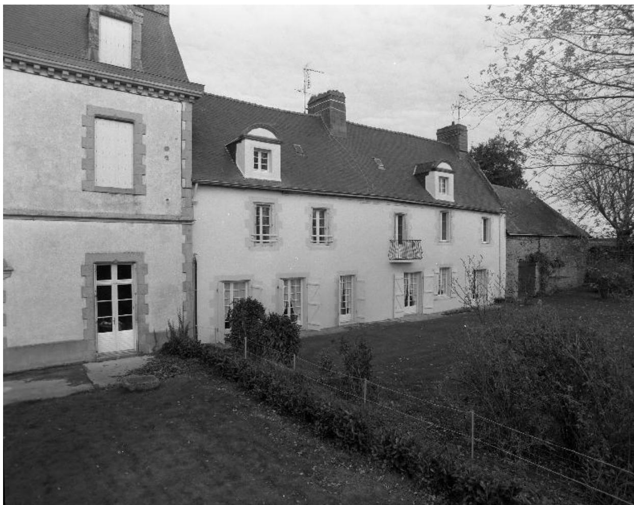
Vue générale d'une partie du logis
