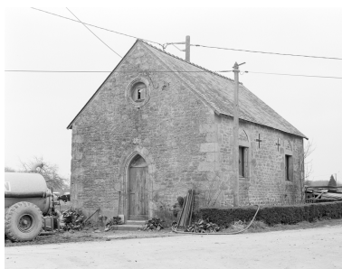
Chapelle, vue générale sud-est. Phot. Bernard Bègne IVR53_19995600093X
