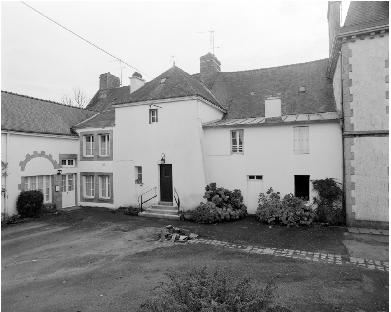
Elévation nord, vue générale.
