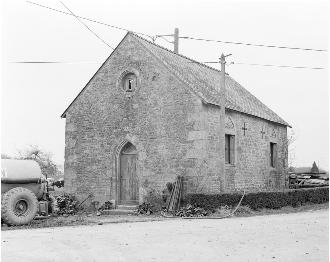
Chapelle, vue générale sud-est.
