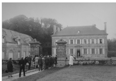
Vue générale depuis le portail d'entrée Phot. Elise Lauranceau IVR53_20052904393NUCB
