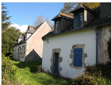
Quatrième et cinquième maisons de l'édifice logistique de la Marine Phot. Guillaume Marie IVR53_20082908395NUCA
