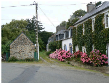
Vue générale de l'édifice logistique de la Marine devenu auberge de jeunesse Phot. Lénéaig L'Aot IVR53_20072908939NUCA
