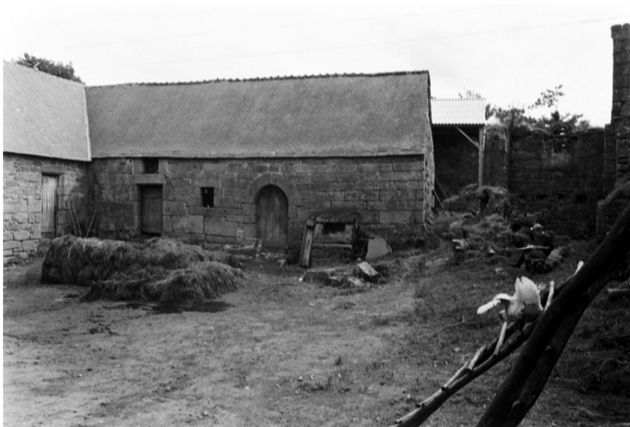
Face nord des communs sud et puits
