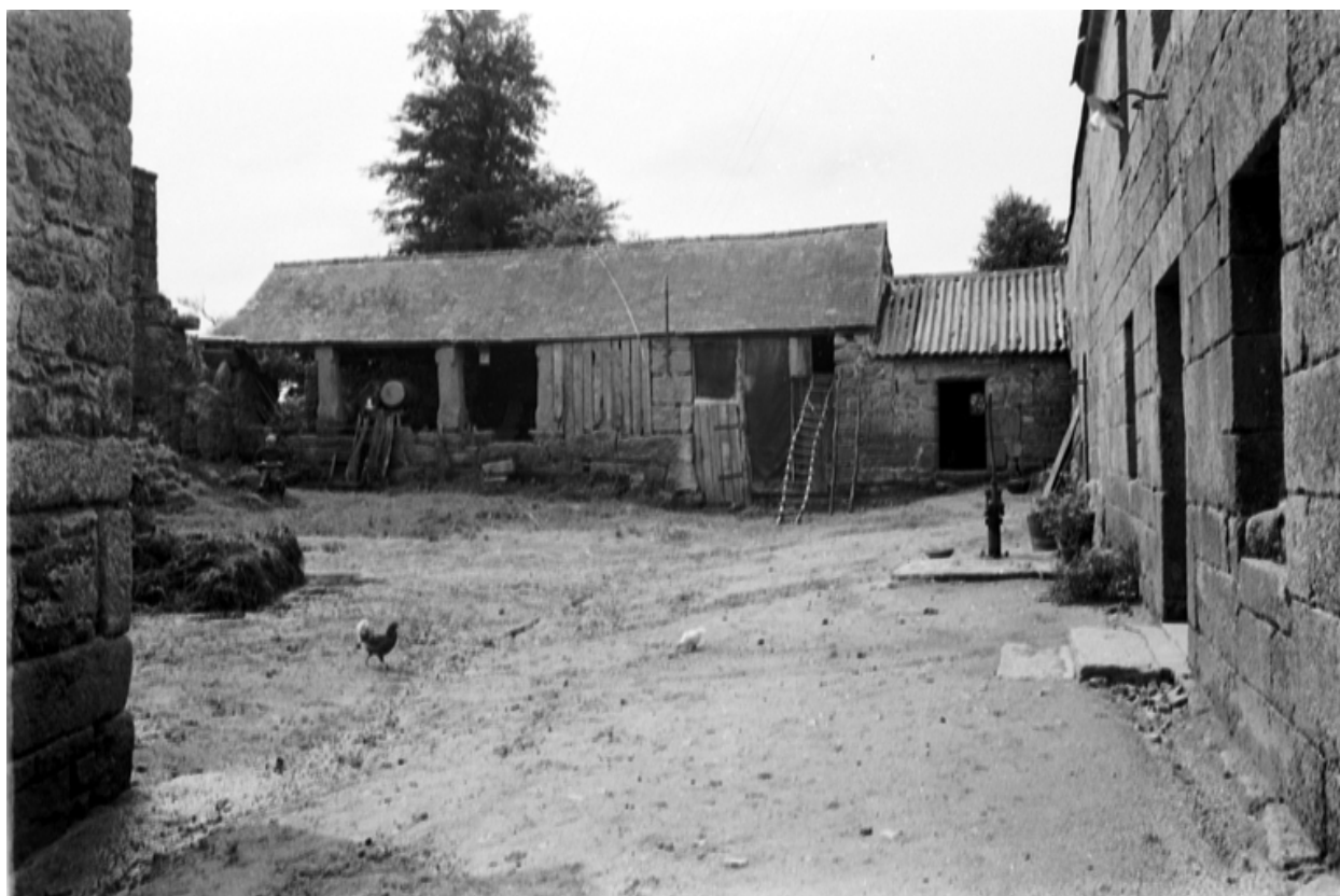
Vue de la cour et du hangar
