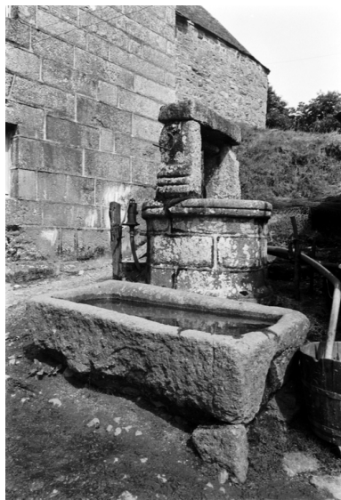
Puits : vue générale Phot. Claude Novello IVR53_19672200214Z
