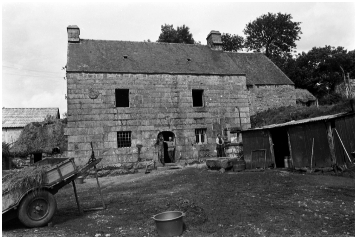
Face sud : vue générale
