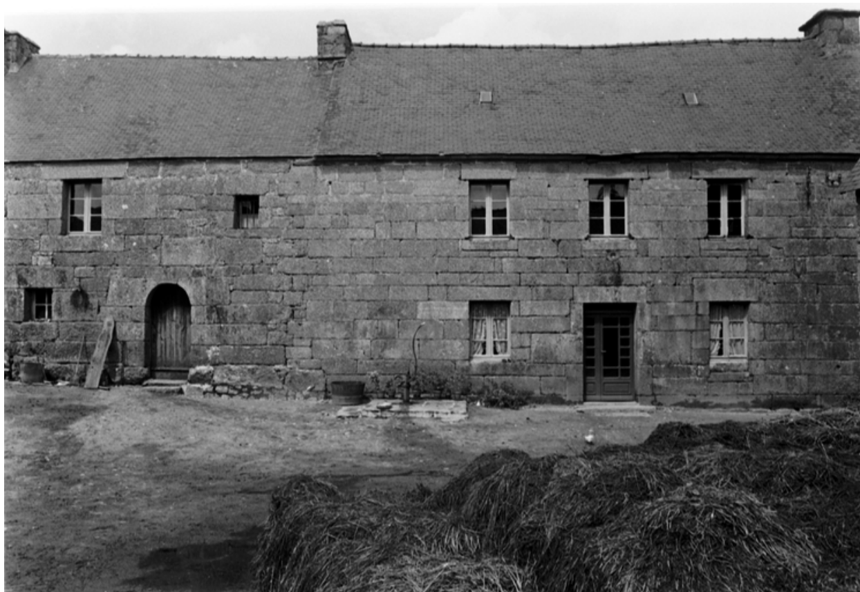
Face sud du logis principal
