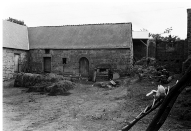
Face nord des communs sud et puits Phot. Claude Novello IVR53_19672200209Z
