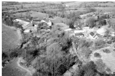
Village de saint Cognan : vue aérienne prise du sud est Phot. G.A.L.A.T. IVR53_19712200056V
