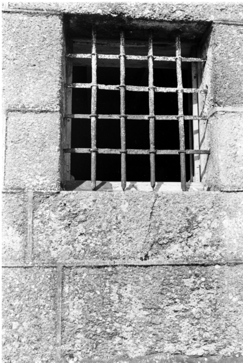
Face sud : détail de la grille protégeant la fenêtre ouest du rez-de-chaussée
