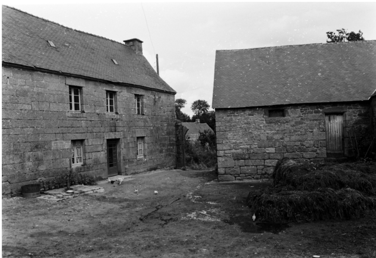
Vue de l'angle nord est de la cour
