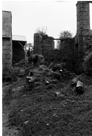
Ruines au sud ouest de la cour Phot. Claude Novello IVR53_19672200210Z
