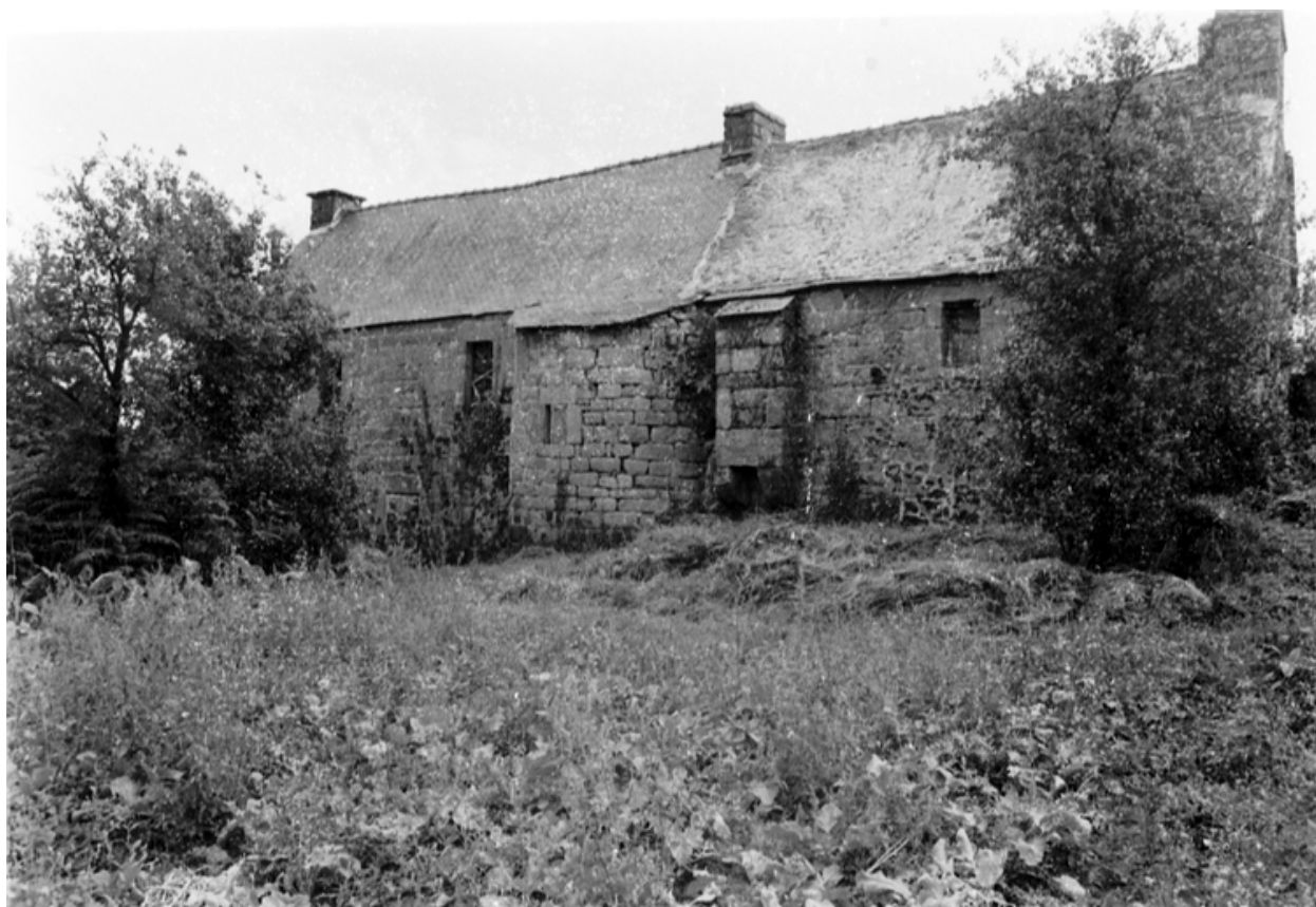
Face nord du logis principal
