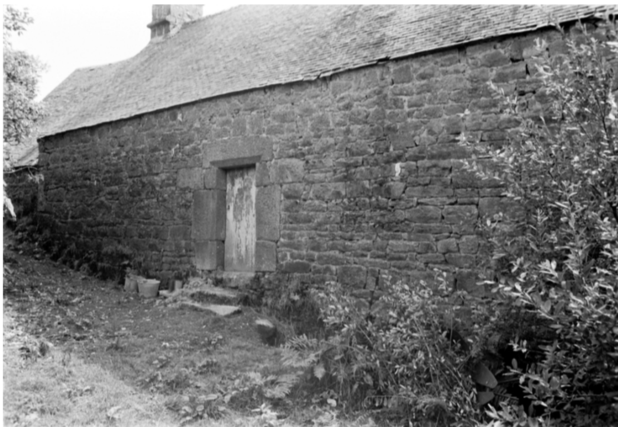
Face nord : vue générale
