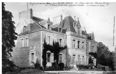
Vue générale Phot. Elise Lauranceau IVR53_20045606207NUCB
