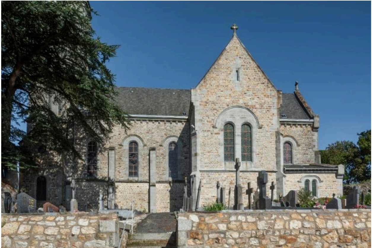
Vue d'ensemble de la façade sud de l'édifice
