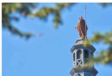
Vue d'ensemble de l'arrière de la statue sur son lanternon Phot. Léna Leroy IVR53_20243500914NUCA
