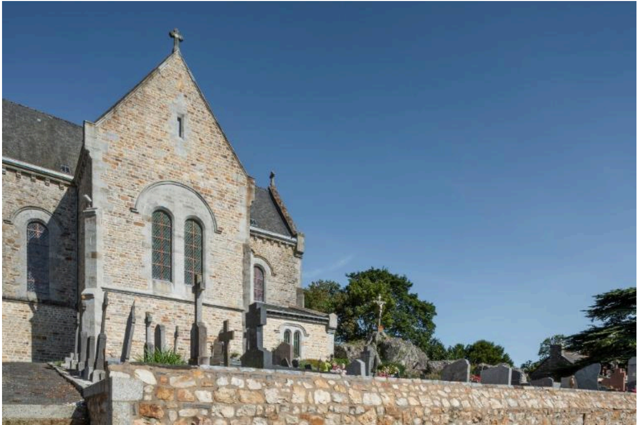
Vue d'ensemble de la façade sud et du cimetière
