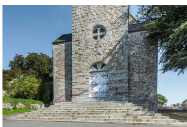
Vue d'ensemble de la façade ouest de l'édifice Phot. Léna Leroy IVR53_20243501168NUCA
