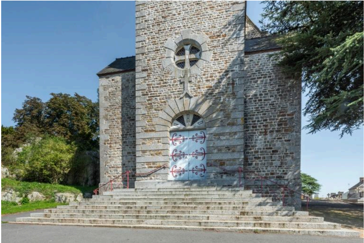
Vue d'ensemble de la façade ouest de l'édifice
