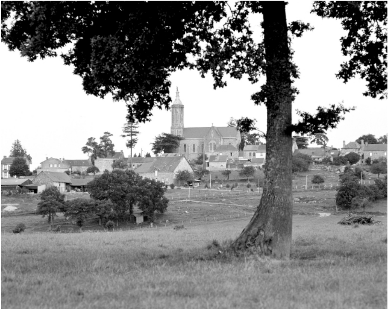
Vue de situation sud
