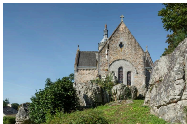
Façade est de l'édifice précédée du calvaire Phot. Léna Leroy IVR53_20243501164NUCA
