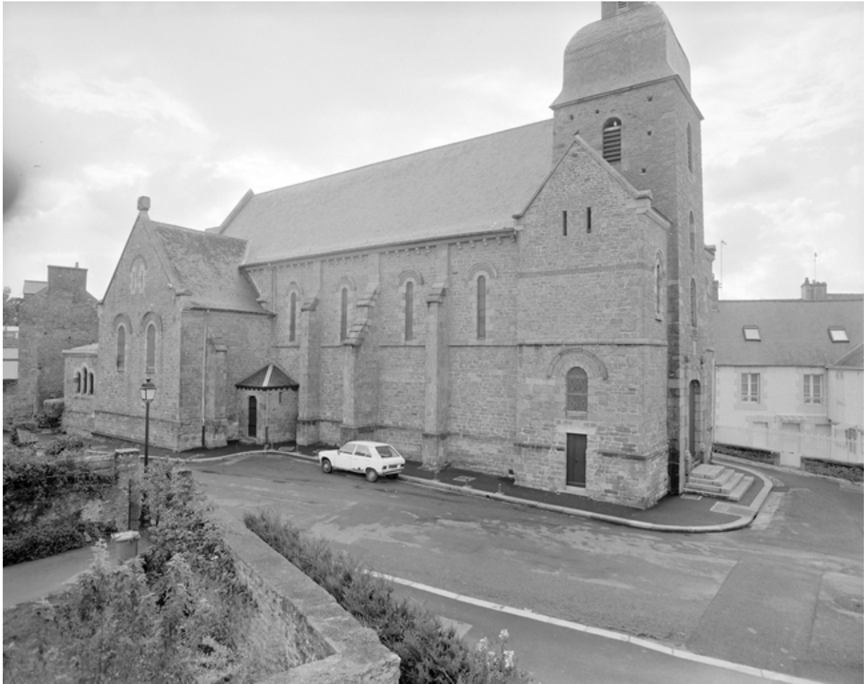
Elévation Nord : vue générale.
