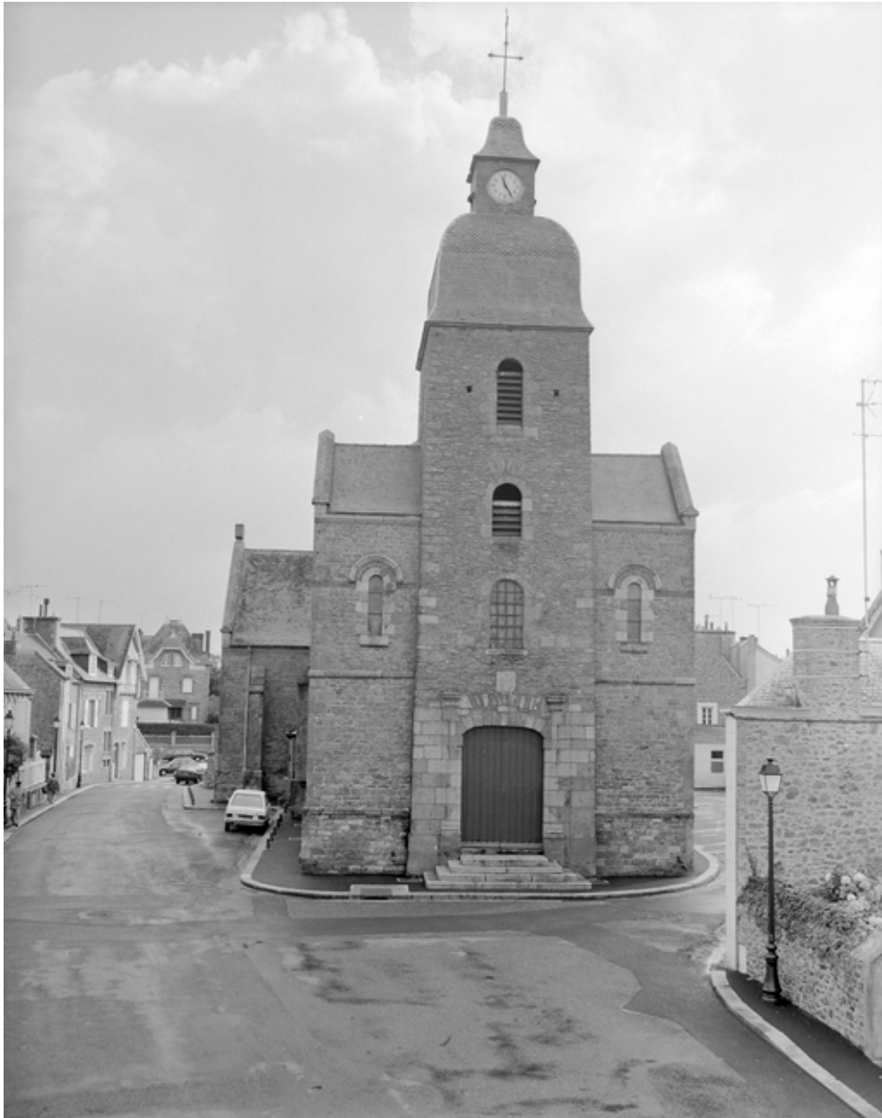
Elévation Ouest : vue générale.
