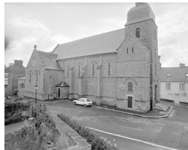
Elévation Nord : vue générale. Phot. Guy Artur, Phot. Norbert Lambart IVR53_19943501858X
