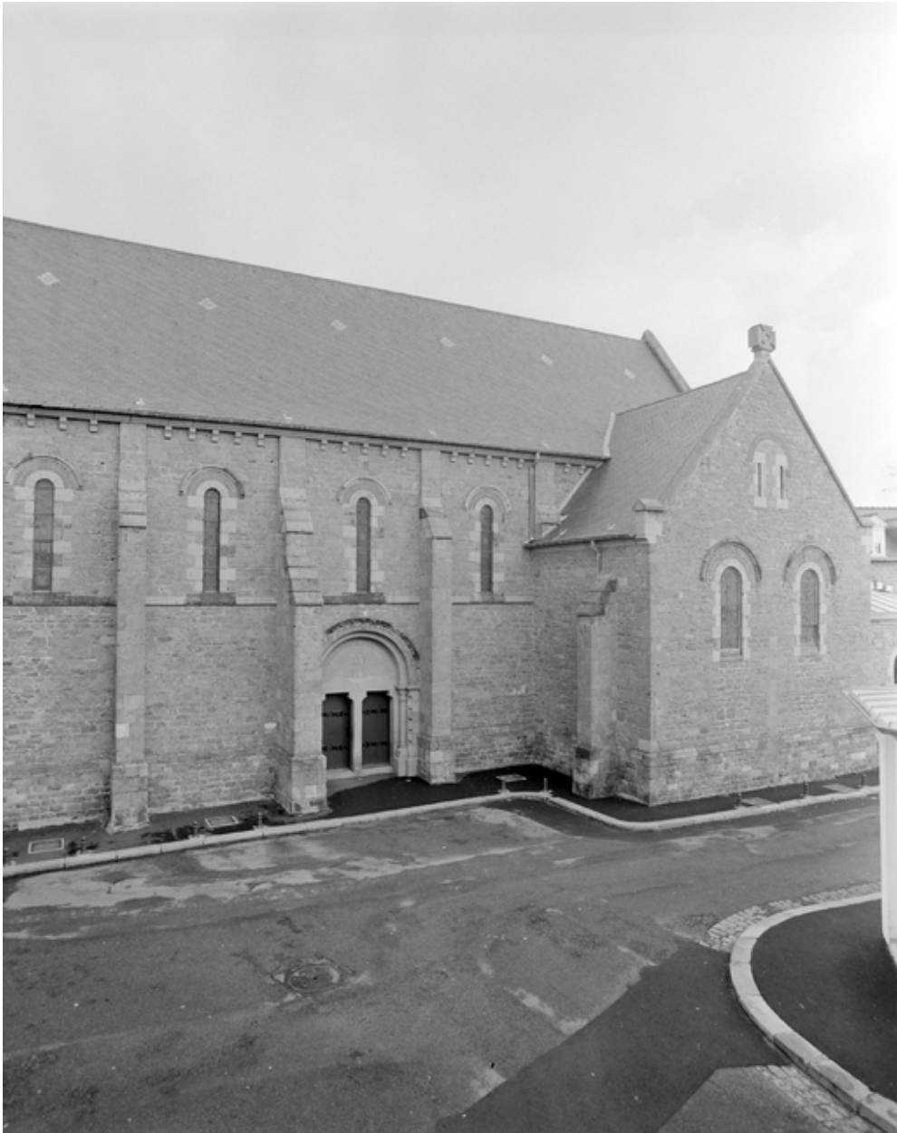
Elévation Sud, partie Est : vue générale.
