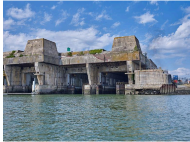
Vue depuis le sud-est : entrée des alvéoles E, F et G. A l'angle du "KIII", casemate pour canon et mitrailleuse Phot. Bernard Bègne IVR53_20215600528NUCA
