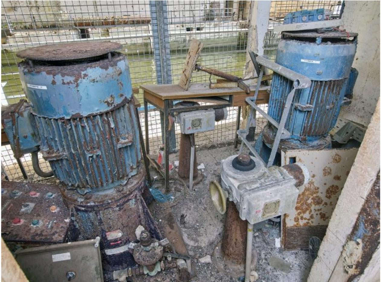
Vue des deux moteurs électriques de deux pompes du bassin (pompes situées entre les bassins F et G)
