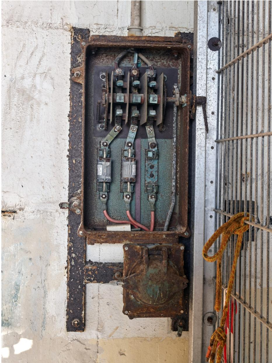
Vue du boîtier (ouvert) de l'une des prises électriques triphasées du bassin F
