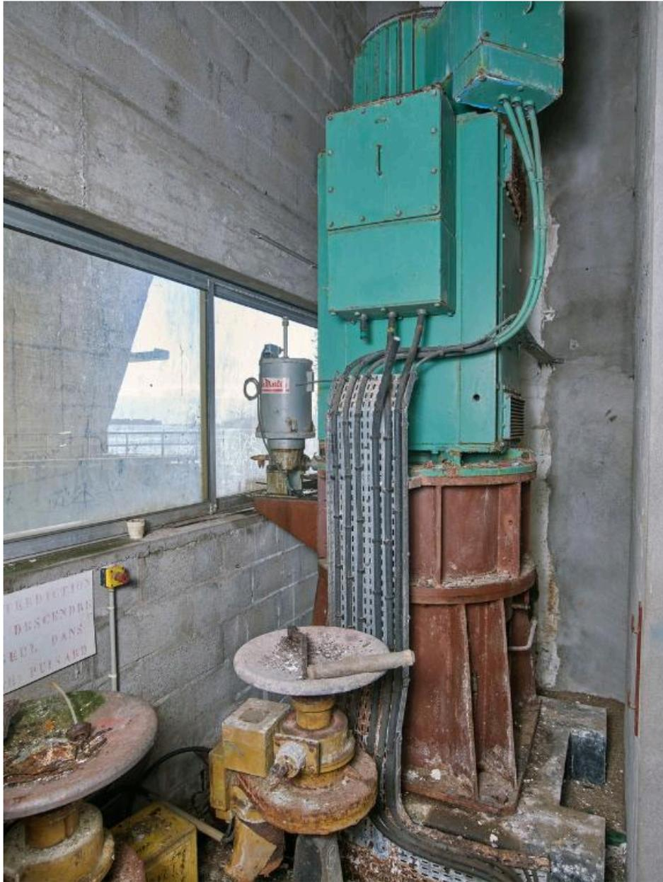
Vue du corps de pompe du bassin F. Au premier plan, la commande à volant de la pompe. Une manivelle est posée sur le volant
