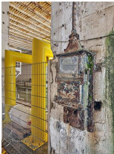
Vue du boîtier (fermé) de l'une des prises électriques triphasées du bassin F. Sur le boîtier : informations ("115 v 60 Hz 125 A Bassin F") et consignes de sécurité
