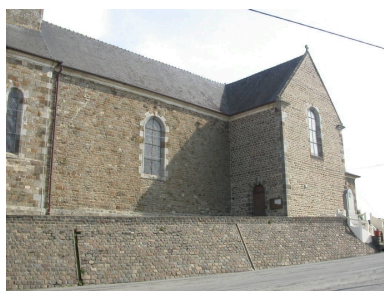
Façade sud de l'église Phot. Stéphanie Ménard IVR53_20063505900NUCA
