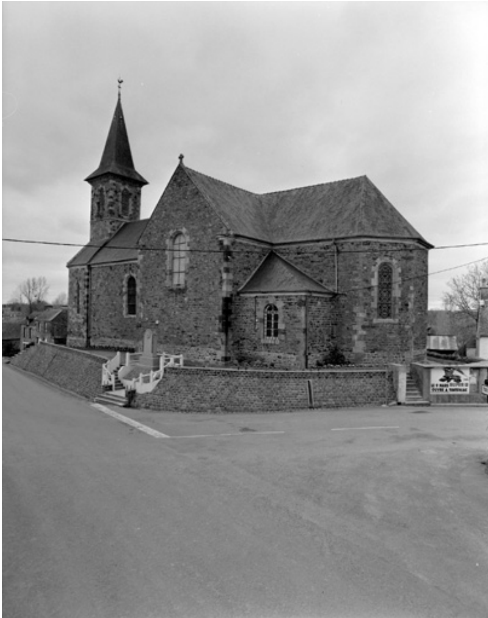
Elévation Sud : vue générale
