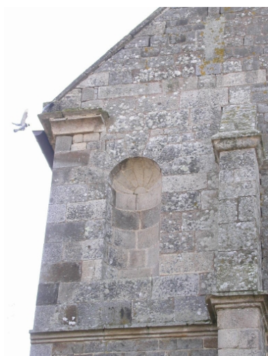
Niche de la façade ouest Phot. Stéphanie Ménard IVR53_20063505903NUCA
