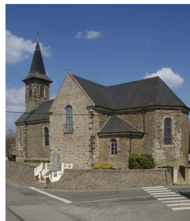
Vue générale sud-ouest Phot. Bernard Bègne IVR53_20063500520NUCA
