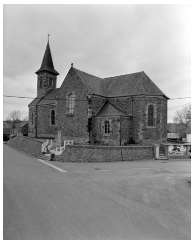
Elévation Sud : vue générale Phot. Guy Artur, Phot. Norbert Lambart IVR53_19943500790X
