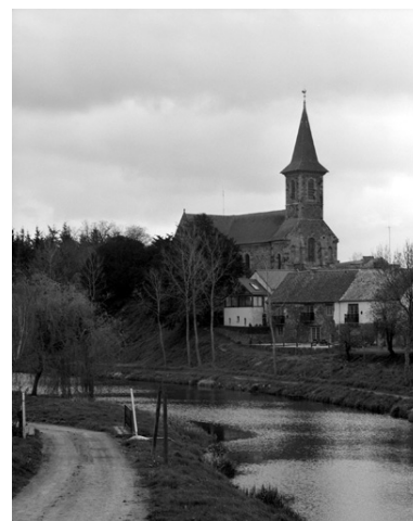
Elévation Nord : vue générale Phot. Guy Artur, Phot. Norbert Lambart IVR53_19943500733X
