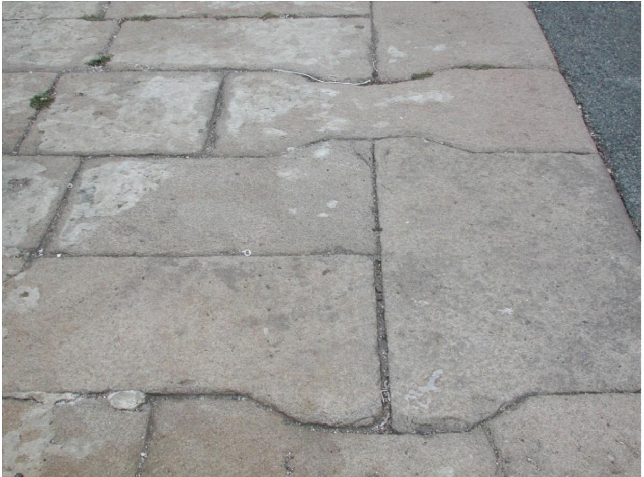
Assemblage des pierres de granit sur le parapet du quai du Linkin
