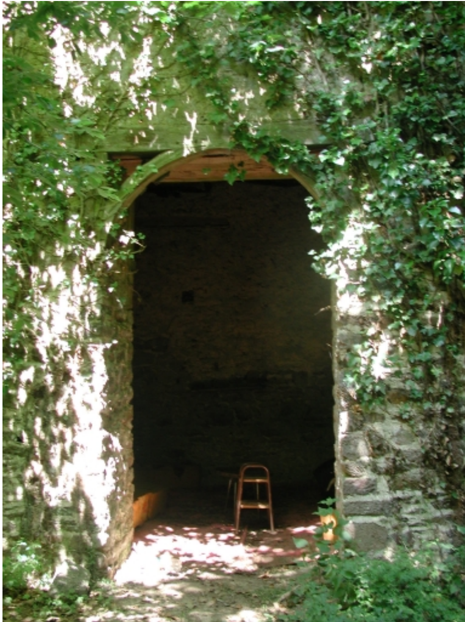
Détail de la porte d'accès à la tour carrée
