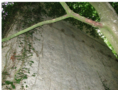
Mur en terre de la tour située au nord ouest du château Phot. Sabrina Dalibard IVR53_20033513459NUCA
