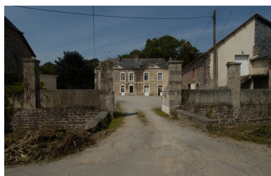
La façade est vue du portail d'entrée Phot. Norbert Lambart IVR53_20033501331NUCA
