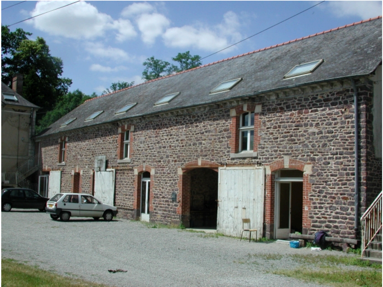
Bâtiment situé au nord du château
