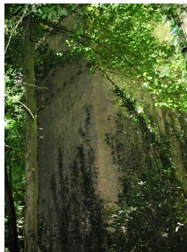
Tour quadrangulaire située au nord ouest Phot. Sabrina Dalibard
