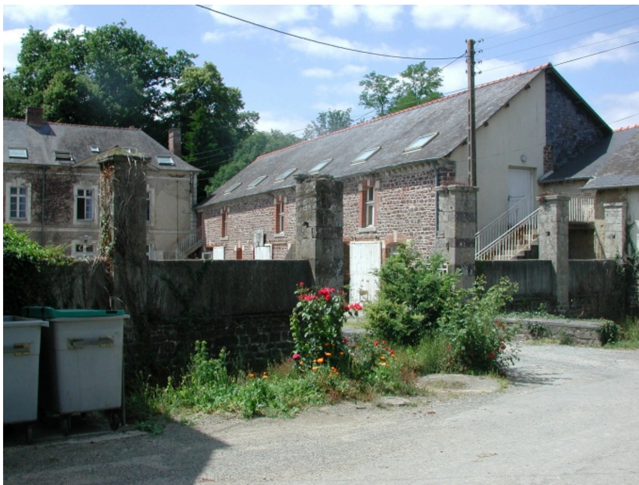
Ancien portail d'entrée
