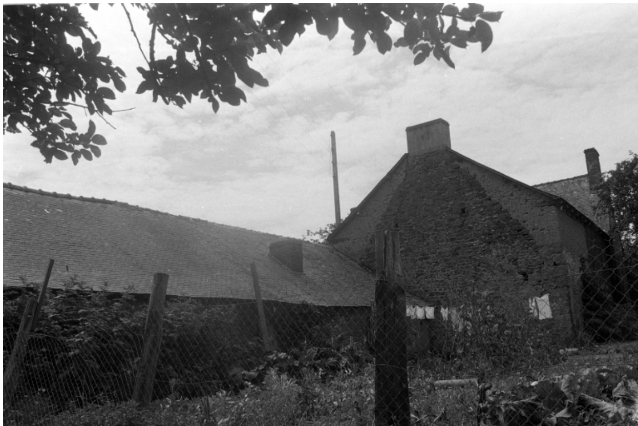
Détail du pignon : maçonnerie et bauge
