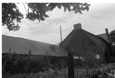
Détail du pignon : maçonnerie et bauge Phot. J. R. Trochet IVR53_19753501181Z
