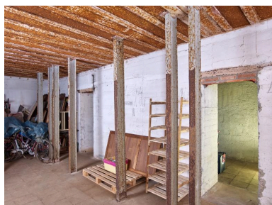
Vue intérieure : grande salle nord. Les poutrelles verticales permettaient de caler les munitions (en caisse en bois pour deux projectiles, sur 6 ou 7 caisses de hauteur ou en container métallique simple) et de délimiter un couloir de distribution Phot. Bernard Bègne IVR53_20255600863NUCA
