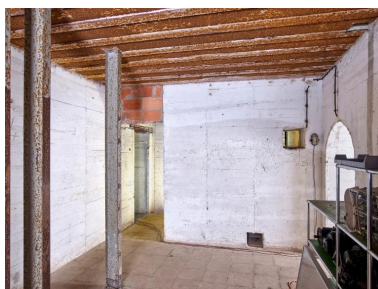
Vue intérieure : grande salle nord. Les poutrelles verticales permettaient de caler les munitions (en caisse en bois pour deux projectiles, sur 6 ou 7 caisses de hauteur ou en container métallique simple) et de délimiter un couloir de distribution Phot. Bernard Bègne IVR53_20255600864NUCA
