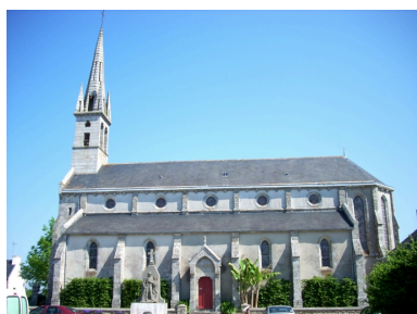
Pleuven, église paroissiale Saint-Mathurin : élévation sud Phot. Gwénaél Fauchille IVR53_20082905953NUCA
